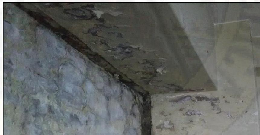
Figure 6: Falla de las vigas principales.
