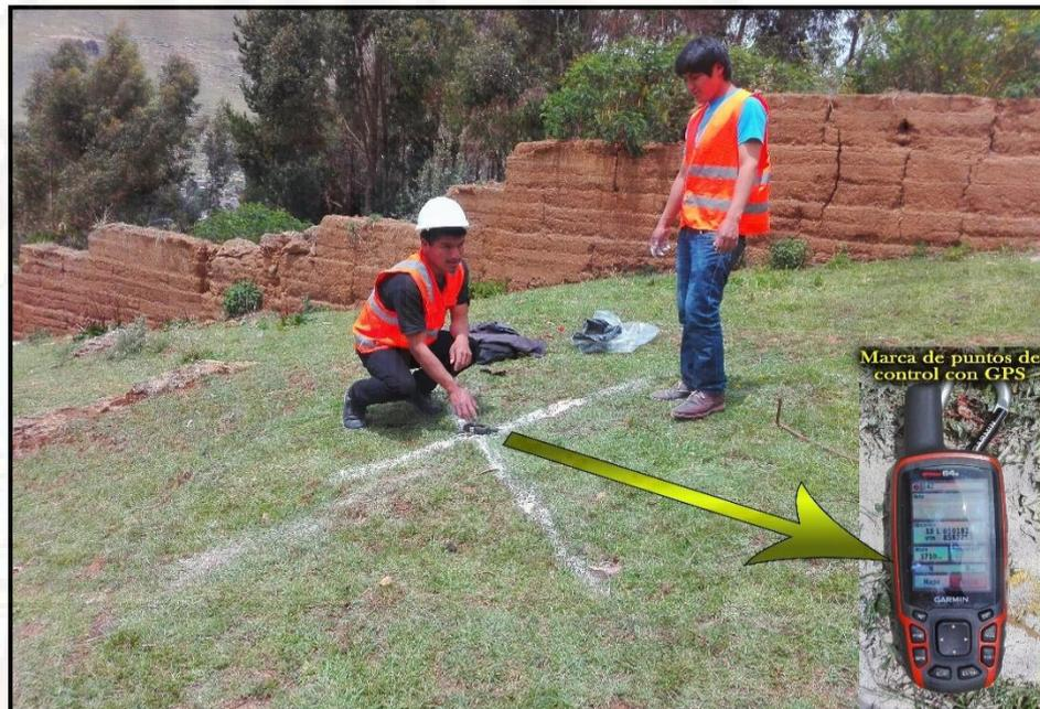
**Figura 53.** Demarcación de 4 puntos de control, en forma de cruz con yeso. Las cuales deben ser visibles para el drone, luego se procede a tomar las coordenadas UTM con el GPS.
