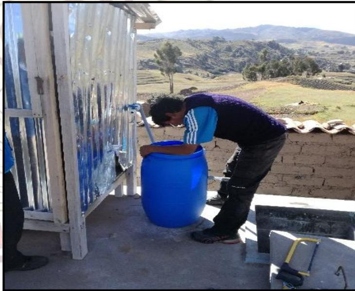
**Fotografía 34.** Tanque difusor de solución clorada.
