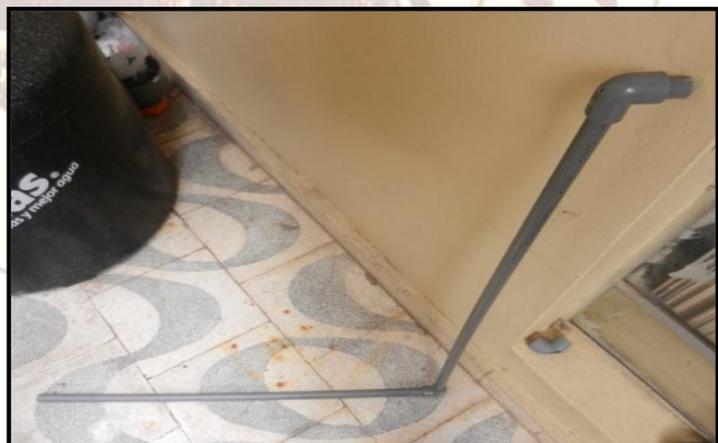
**Fotografía 15.** Soporte para flotador
