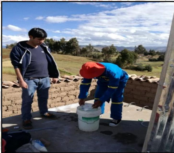
**Fotografía 24.** Preparación de la solución clorada
