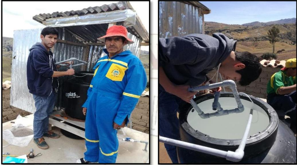
*Fotografía A 5. Instalación del sistema de cloración por goteo con flotador adaptado.*
