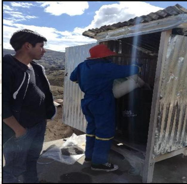
**Fotografía 25.** Llenado del tanque con la solución clorada
