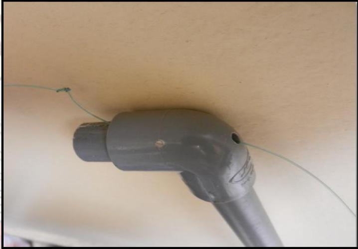
*Fotografía 16.* Montaje del hilo nylon.
