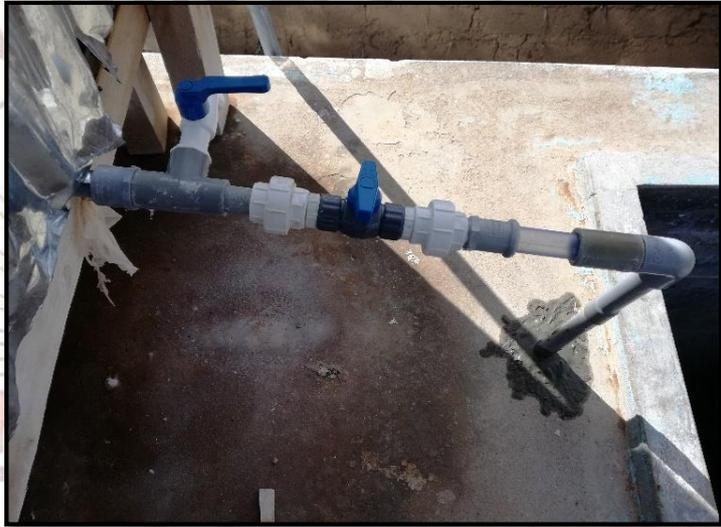
**Fotografía 20.** Instalación de grifo y uniones universales
