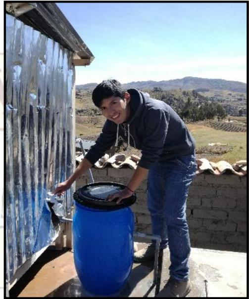
*Fotografía A 8. Instalación del sistema de cloración por goteo por embalse*
