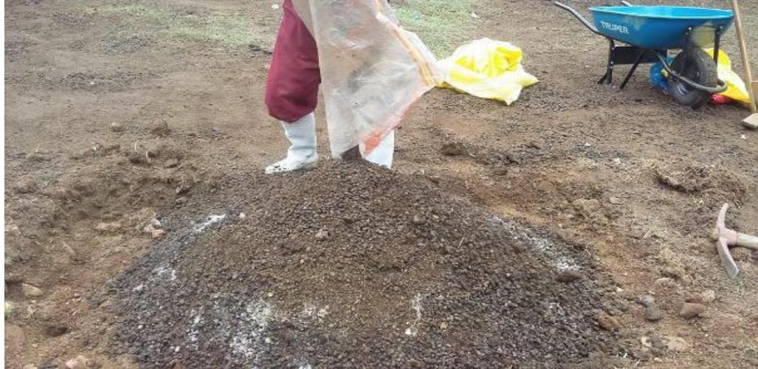
Figura 4. Agregando cal por capas.
