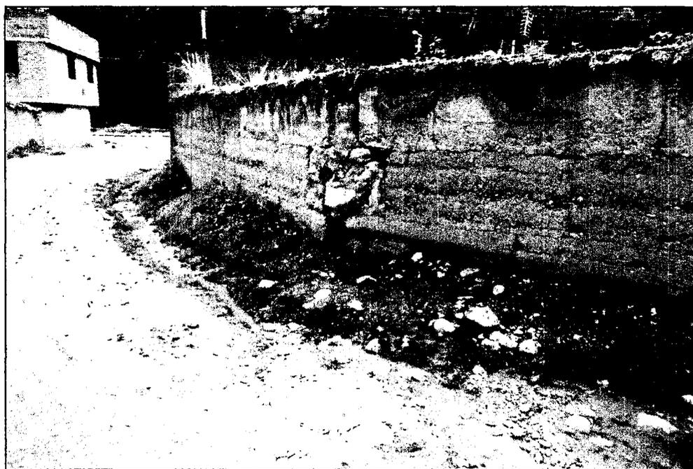
**FOTO 10:** Aguas de lluvia discurriendo por canales naturales (humedecimiento de muros rústicos)
