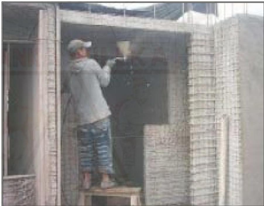
*Figura 33: Proceso de revoque de capa inferior losas estructurales paneles*
