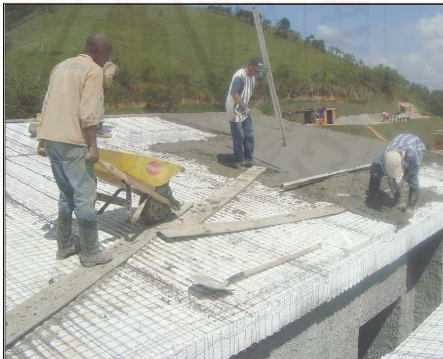
Figura 32: Proceso de vaciado de capa superior losas estructurales paneles Emedos (M-2)
