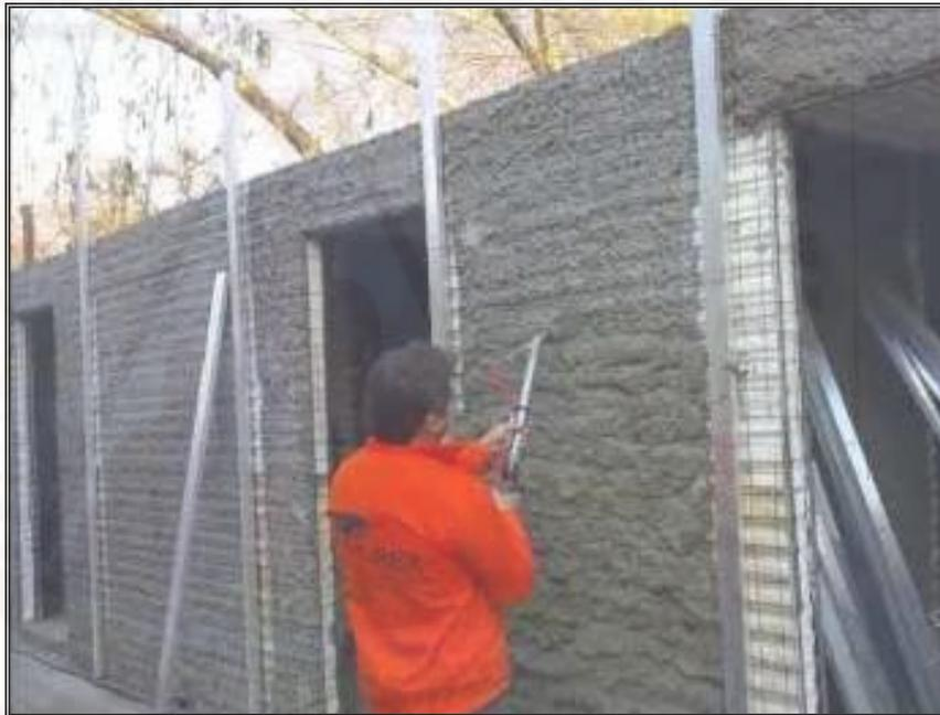
*Figura 30: Proceso de revoque de paneles Emedos (M-2)*
