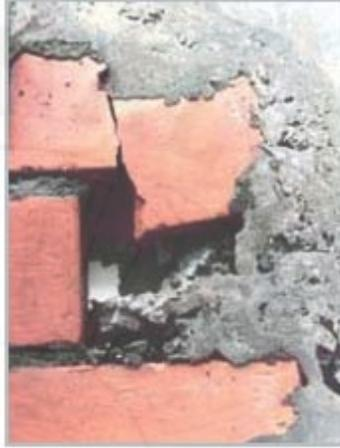
Figura 46: Cangrejas en el vaciado de columnas de amarre
