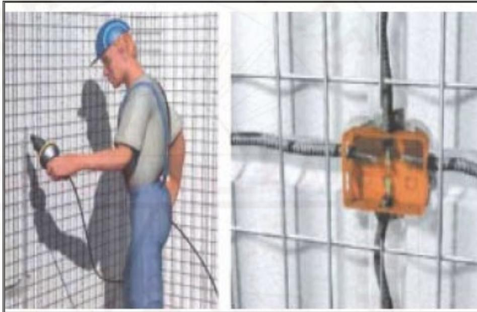
*Figura 28: Contracción con fuego del poliestireno para canalización*
