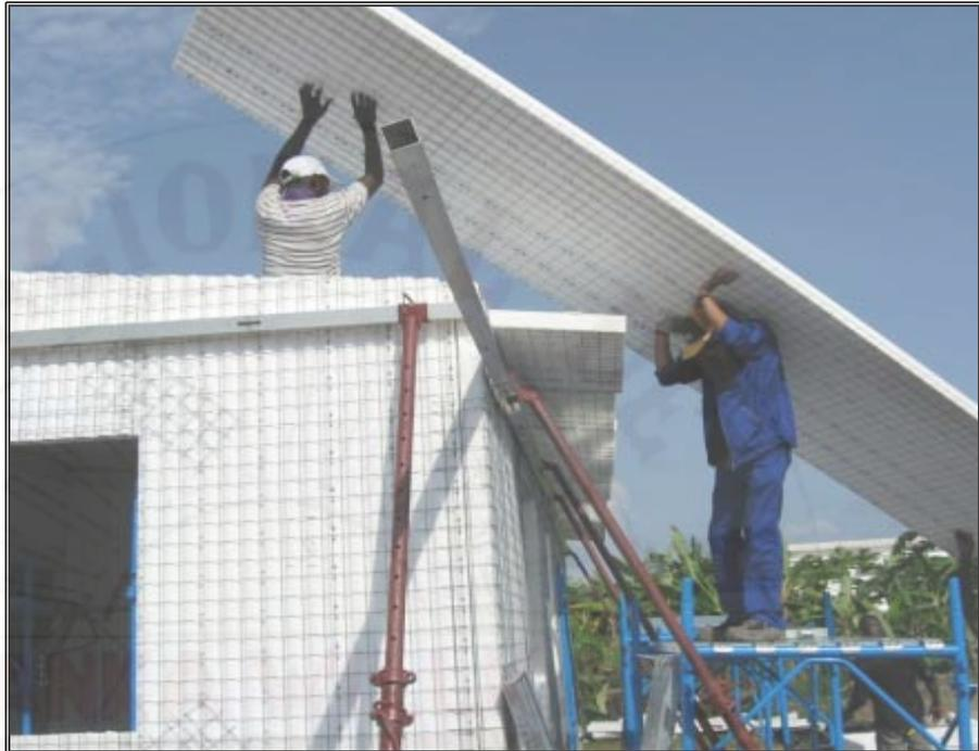
*Figura 29: Colocación de paneles de losa.*
