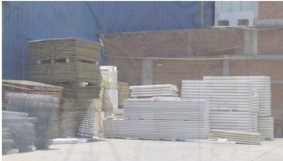
*Figura 17: Almacenamiento de paneles, mallas y aceros de refuerzo*
