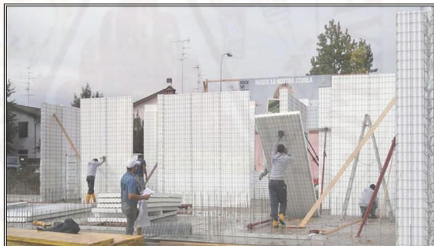
*Figura 25: Armado completo de paredes*
