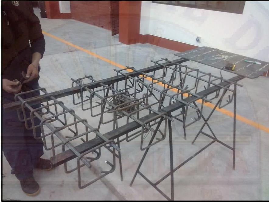
Armado de las vigas de concreto
