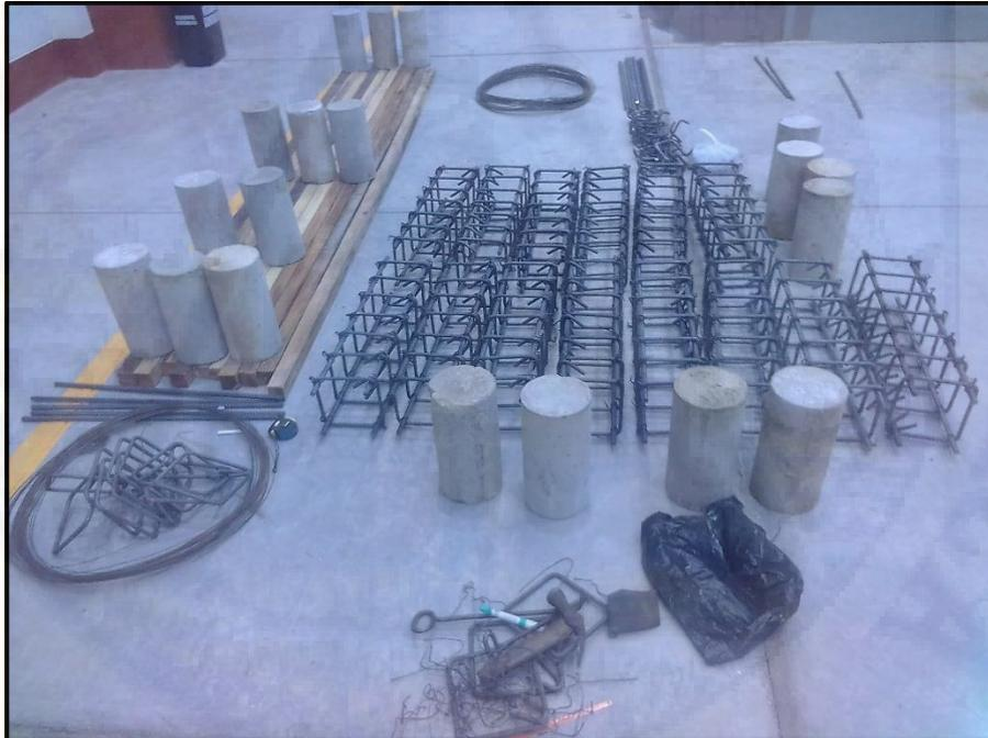
Armazones terminados para las vigas de concreto armado
