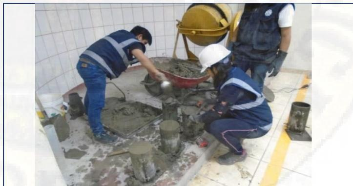
**Figura N° 41. Colocado de mezcla de concreto en la brigetas**
