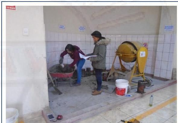
**Figura N° 44. Mezclado uniforme para evitar la segregación**
