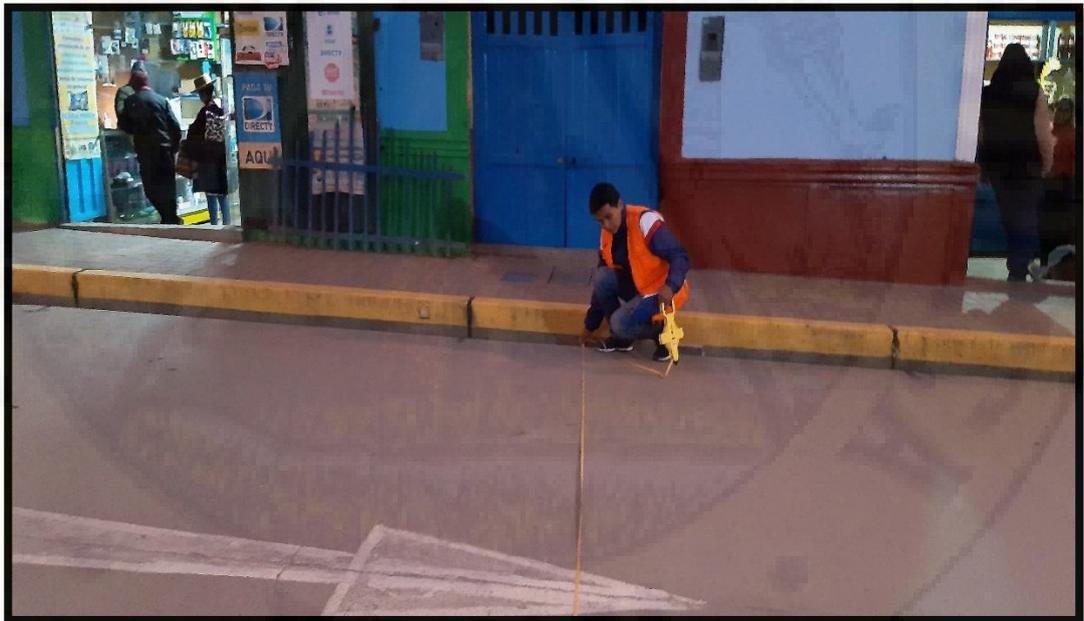
*Figura 67:* Medición de las vías que comprende la red Vial.
