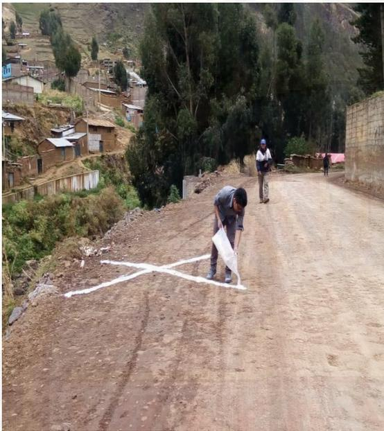
**IMAGEN N° 10.** Marcado del punto de control N° 02 para el levantamiento topográfico
