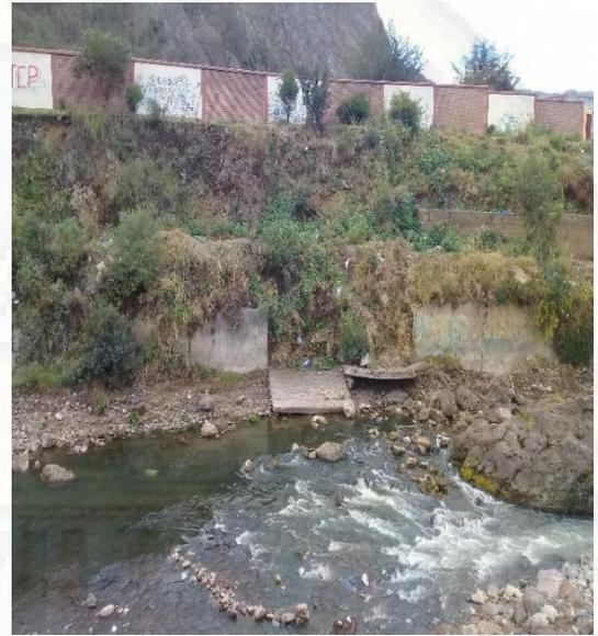
**IMAGEN N° 08.** Los muros de contención se empiezan a derrumbar por la erosión del río.
