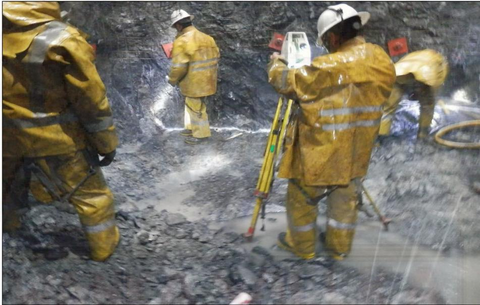
Área de topografía realizando el marcado de la sección y malla de perforación.
