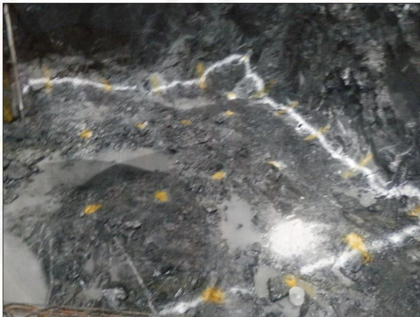
Sección 4.80x2.80m y malla de perforación en medio banco.
