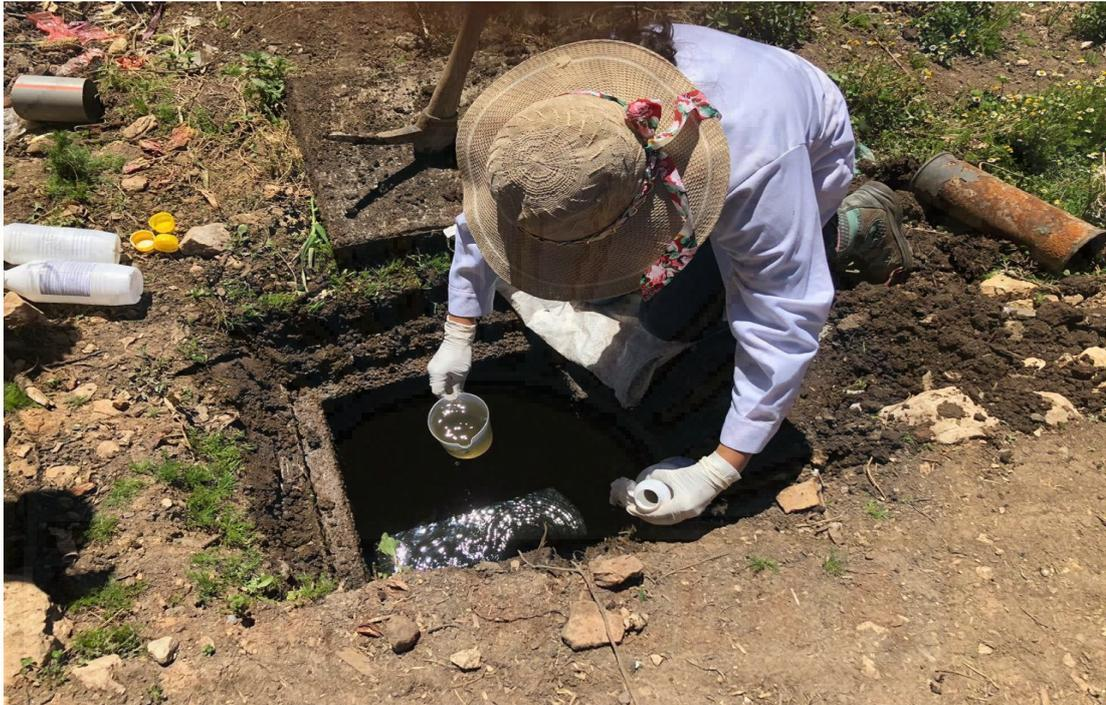
**Fotografía 26.** Punto de monitoreo del efluente a la salida del biodigestor o al ingreso del pozo percolador.
