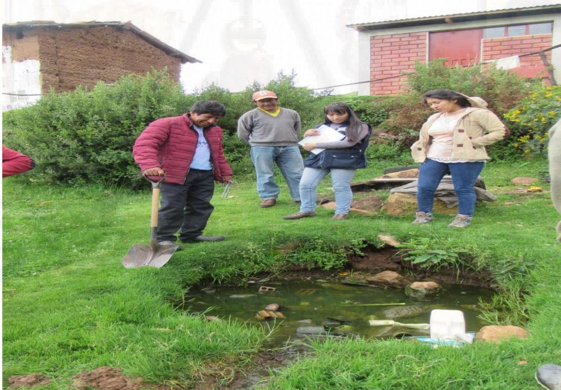
**Fotografía 33.** Colapsó de pozo percolador por mal estudio de suelos y falta de mantenimiento en el sistema.
