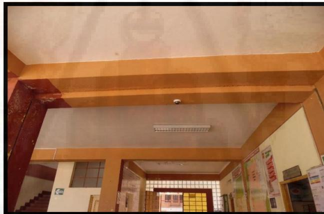
El Colegio Nacional La Victoria de Ayacucho, no cuenta con muros de placas, en los bloques VIII, IX y X, se presencia un desnivel de altura respecto a los otros bloques, de igual manera se observa la mínima deformación visual, de esta forma los diafragmas y los muros trabajan eficazmente. La asignación de la calificación es para todo los bloques del colegio.
