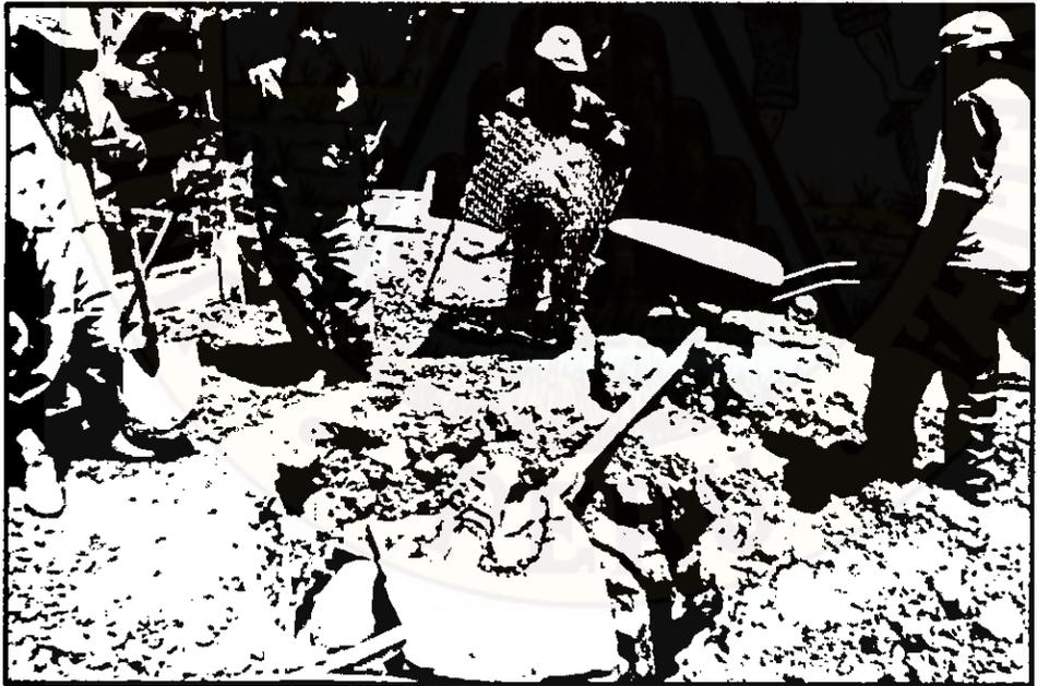
Proceso de compactación de tierra zarandeada alrededor del biodigestor lleno de agua
