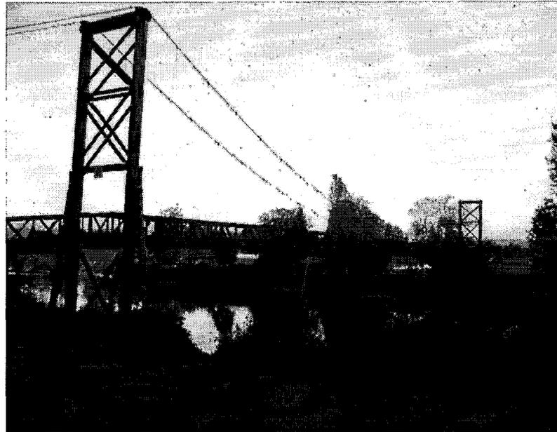
IMAGEN N° 06 Vista lateral en la que se puede apreciar la estructura independiente que permite dar mayor estabilidad al puente
