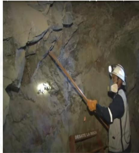
**IMAGEN N°10: Ejemplificación desate de rocas por el supervisor.**
