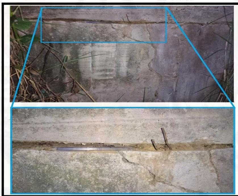
Figura 117. Fisura horizontal dentro del muro de contención.
