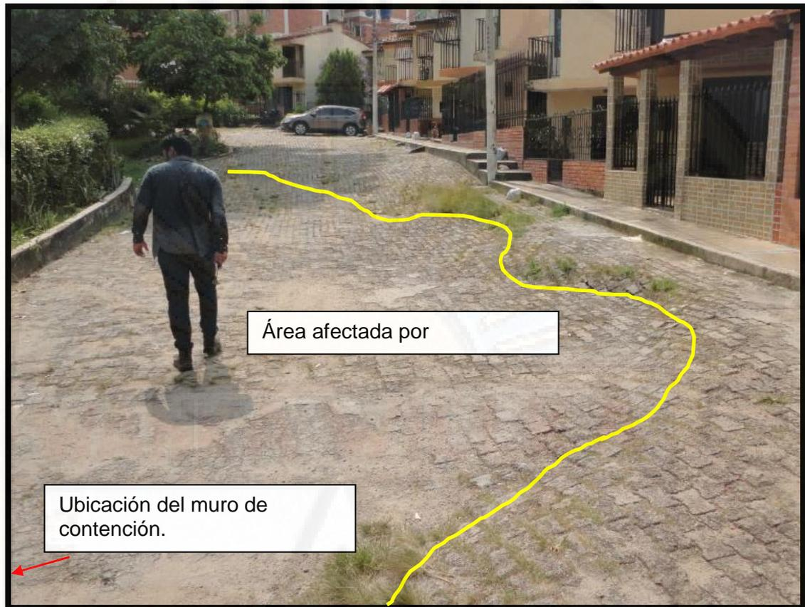
Figura 34. Escarpe de coronación principal del Movimiento en masa. Este es el foco principal de estudio, en donde el muro de contención presente se encuentra desplazado en la vertical (hundimiento) y a su vez fracturado. Fuente: Propia.
