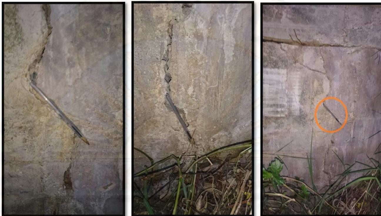
Figura 116. Fisura dentro del muro de contención.
