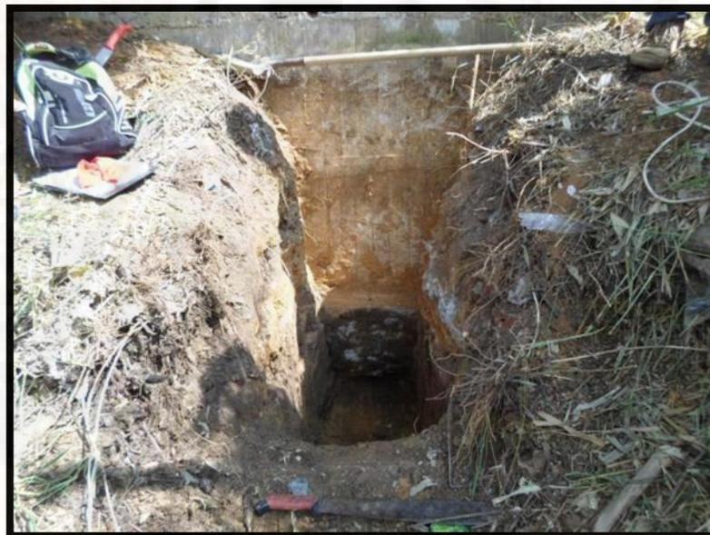
Figura 113. Franja de excavación al pie del muro de contención.
