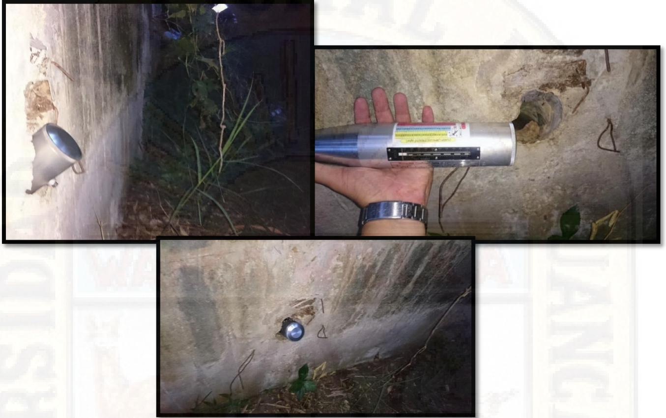
Figura 118. Lloraderos en contrapendiente en el muro de concreto.
