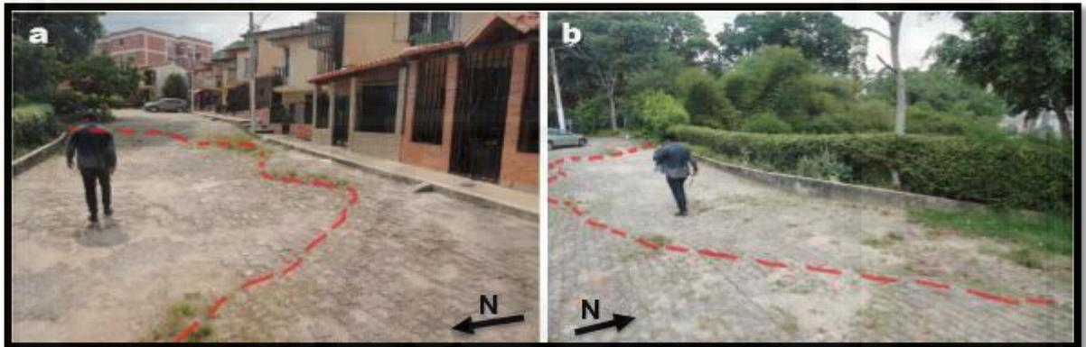
Figura 49. Corona de posible movimiento en masa con presencia de hundimientos en el área del barrio Los Nogales. Fuente: Propia.
