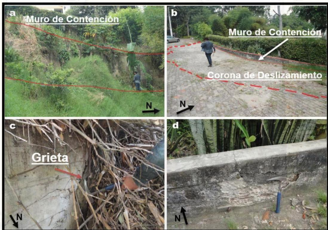
Figura 54. Muros de contención en concreto en el barrio Los Nogales. A) Muro de concreto, B) Franja de coronación del deslizamiento contenido por el muro, C) Grieta de 3 a 4 cm de ancho en la parte derecha del muro y D) Meteorización del muro en el costado derecho (Visto hacia el norte) sobre la vía frente a las viviendas, observándose varillas de acero. Fuente: Propia.
