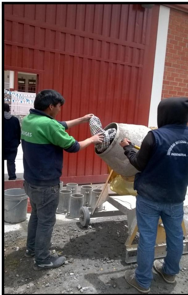
Fotografía 8 : Preparación de la mezcla de concreto para cada tipo de diseño
