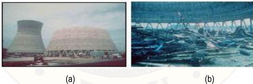
**Figura 2.15:** Colapso de una torre debido a la aplicación de cargas a edades tempranas, en la imagen (a) se observa una torre similar a la del colapso y en la (b) imagen del resultado del colapso (Tomado de IPRF-01-G-002-03-6).
