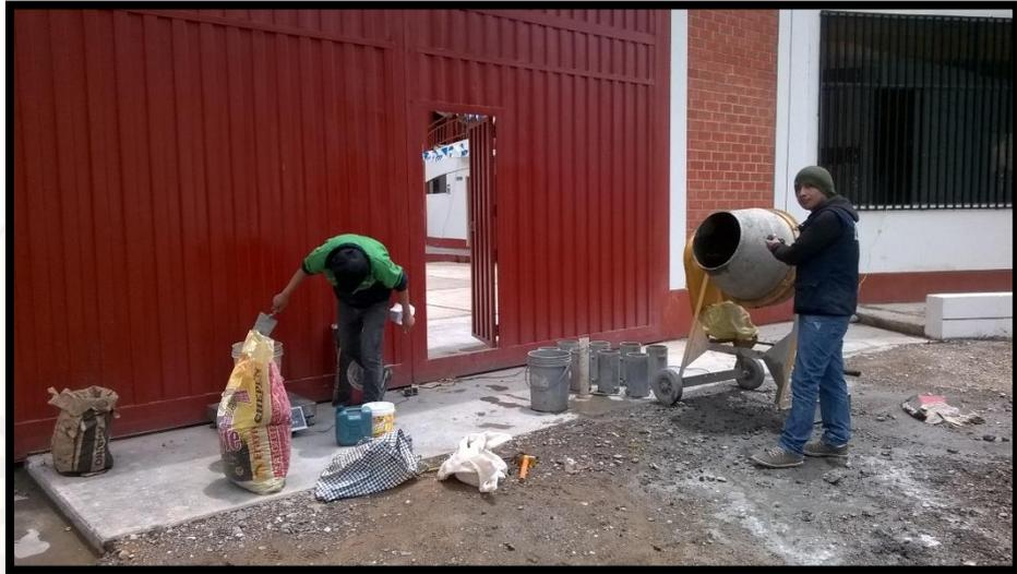
*Figura 2.9:* Preparación del concreto para un  $f'c = 210 \text{ kg/cm}^2$
