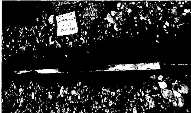
Figura 4.10. Cemento conductivo en SPAT horizontal
