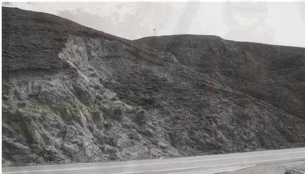
Figura 13. Foto, Rotura circular (Wyllie&Mah, 2004)
