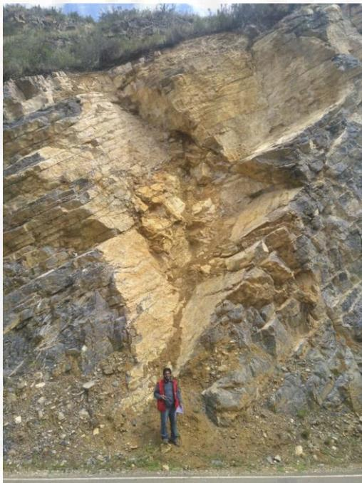
**EG – 4:** Afloramiento del macizo rocoso (caliza), se puede observar los estratos (una familia) y dos diaclasas esporádicas de gran persistencia que formaron tres cuñas, que fallaron por acción de la deficiente voladura, durante el corte del talud.
