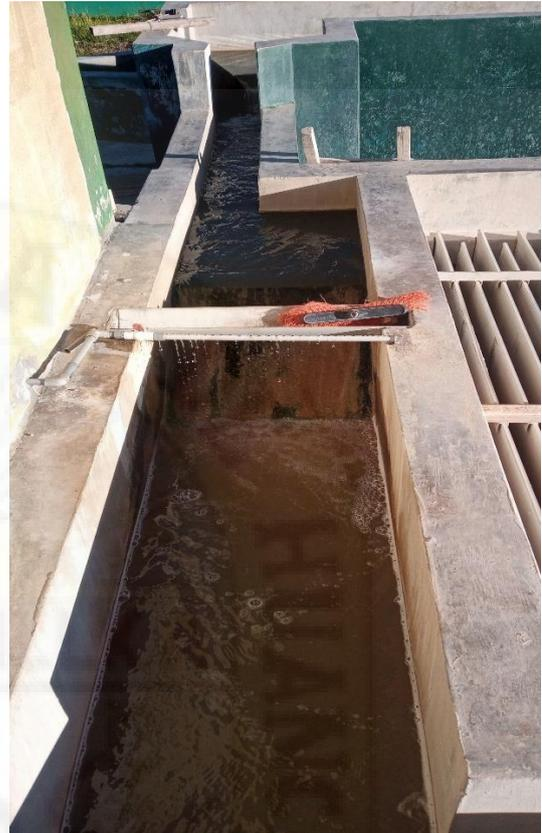
**Fotografía 7.** Registro de datos de campo. **Fotografía 8.** Mezcla rápida de la PTAP.
