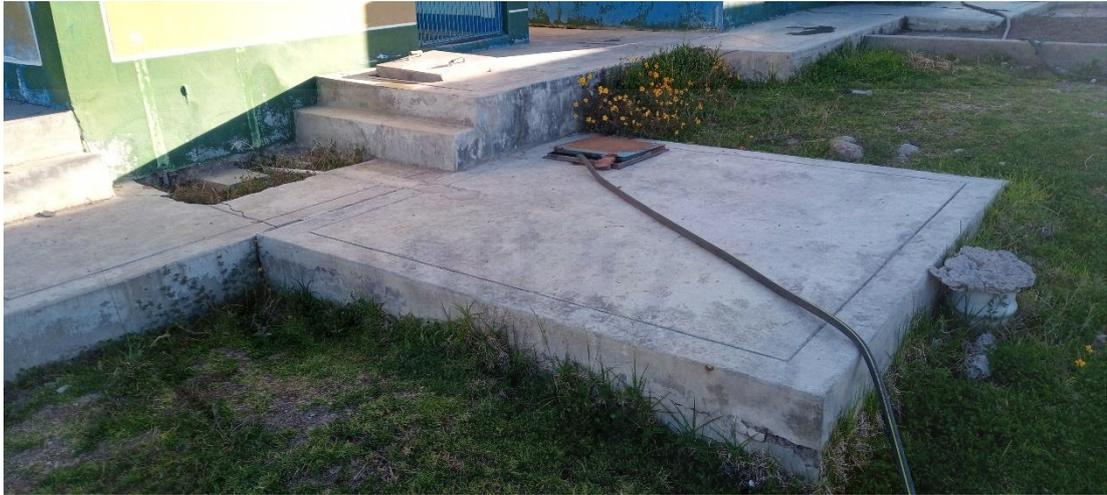
**Fotografía 13.** Cámara de contacto de cloro de la PTAP
