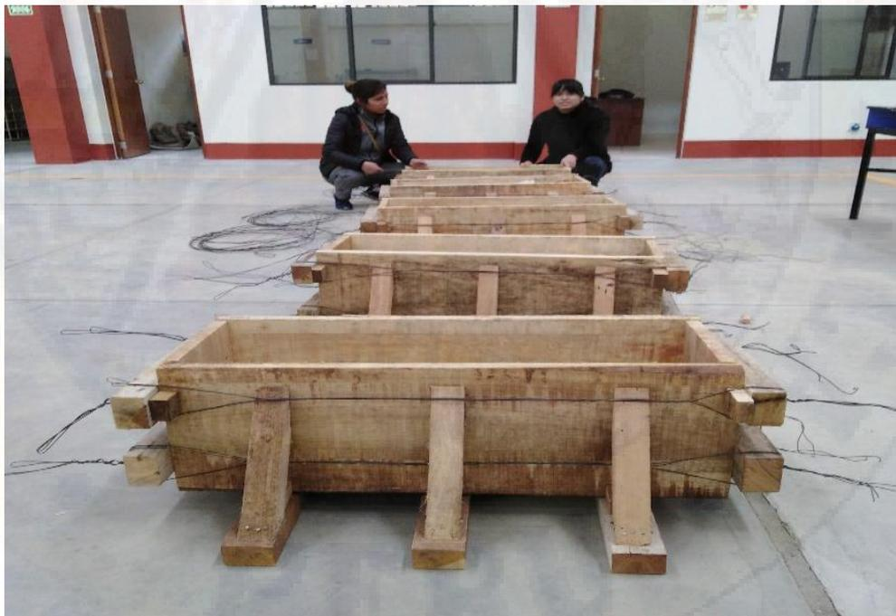
**Fotografía 2:** Encofrados para las vigas.
