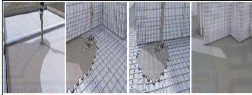
**Figura 33:** Colocado de concreto en la capa superior de las losas estructurales
