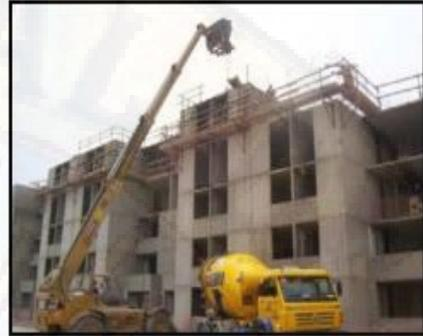
**Figura 45:** Vaciado de concreto con bomba, Vaciado de concreto con brazo telescópico.
