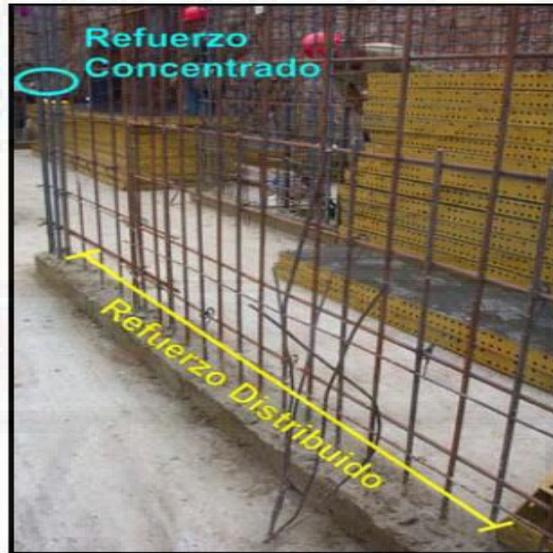
**Figura 41:** Acero de refuerzo concentrado y distribuido en muros
