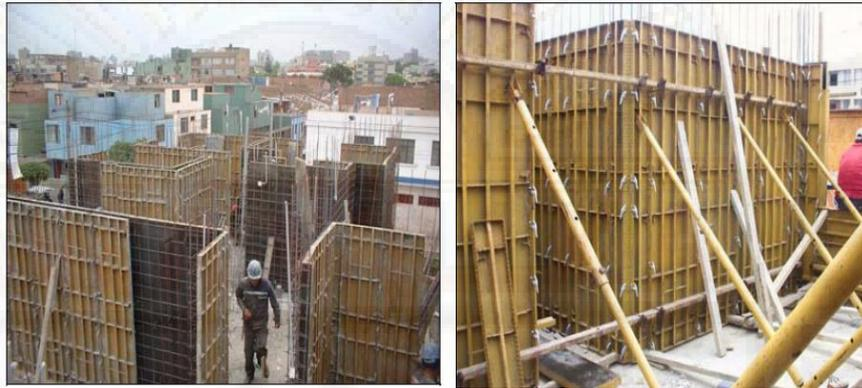
**Figura 44:** Encofrados metálicos
