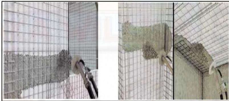
**Figura 32:** Lanzado de mortero y revocado de paneles de pared
