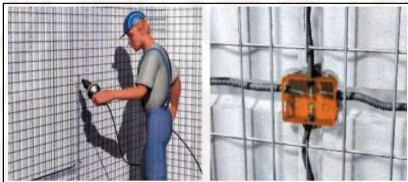
**Figura 29:** Canalización para instalaciones
