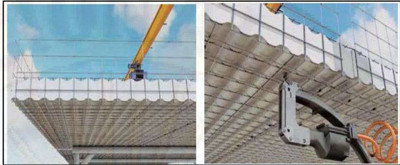
**Figura 30:** Colocación de mallas de refuerzo individual
