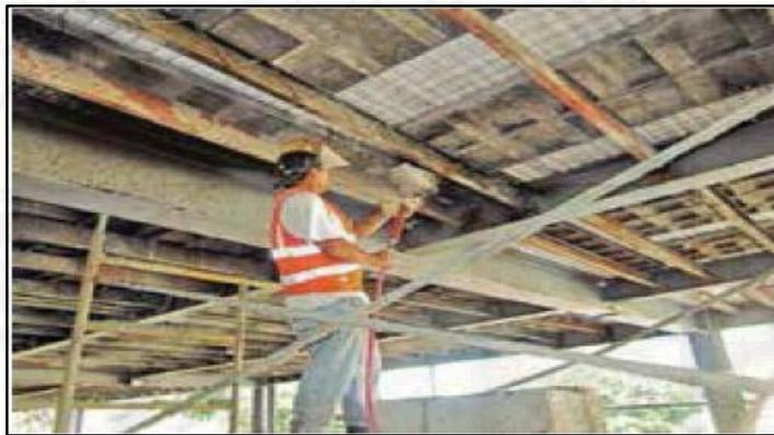
**Figura 34:** Proceso de revoque de capa inferior de losas estructurales
