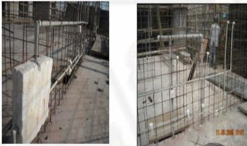
**Figura 43:** Llave de agua colocada antes del vaciado, Instalación de tubería de agua fría y caliente dentro del MDL
