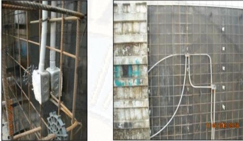
**Figura 42:** Caja eléctrica sujeta a malla electro-soldada, Distribución de tuberías eléctricas
