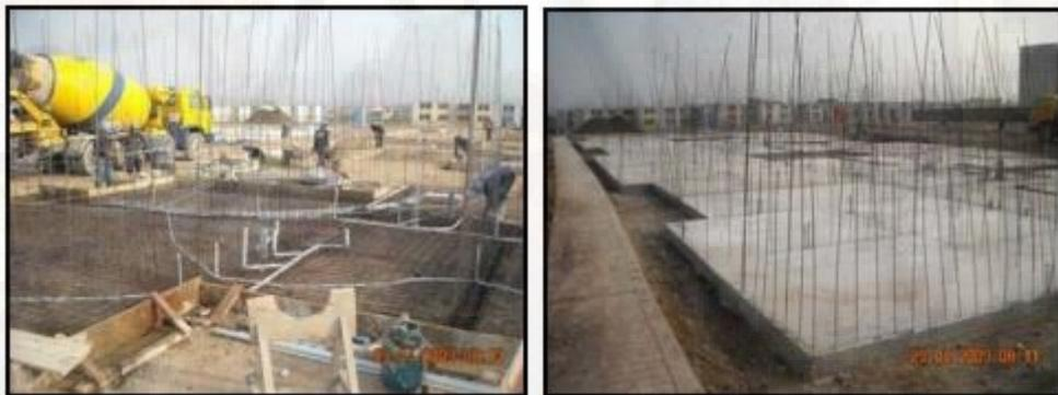
**Figura 40:** Vaciado de platea, Platea terminada
