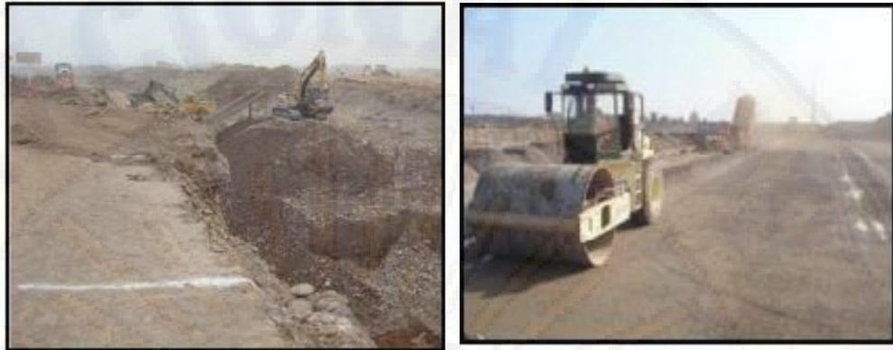
**Figura 38:** Corte y zarandeo de material granular, Compactación en capas de 30 cm
