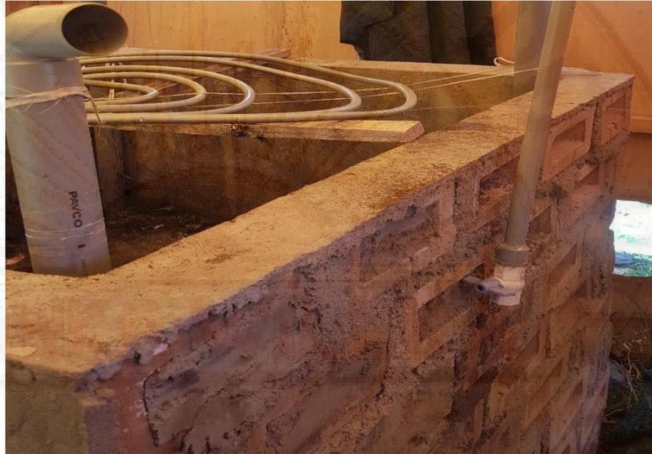
Fotografía 17. Muros del lombrifiltro.
