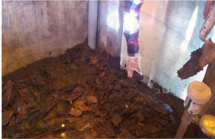
Fotografía 23. Aireación de las primeras capas del lombrifiltro.
