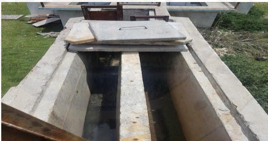
Fotografía 9. Desarenador de la PTAR del Centro Poblado de Huaylacucho.
