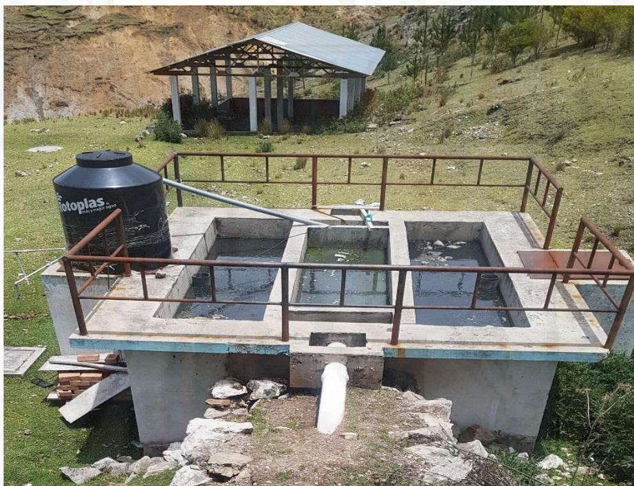
Fotografía 10. Tanque imhoff de la Planta de tratamiento de aguas residuales del centro poblado de Huaylacucho.
