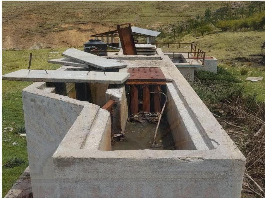
Fotografía 8. Proceso de desbaste de la PTAR de Huaylacucho.
