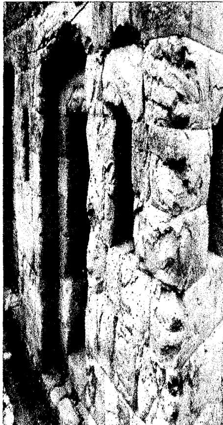
En la integridad de la infraestructura se puede apreciar que parte de las paredes se vienen desmoronando siendo la parte posterior izquierda la más afectada se debe a diversos factores como son la humedad, los incendios producidos en diferentes épocas (1894, 1914, 1938) de los cuales aún queda vestigios en los muros donde podemos encontrar piedras con apariencia negruzca por acción del fuego y del humo.
