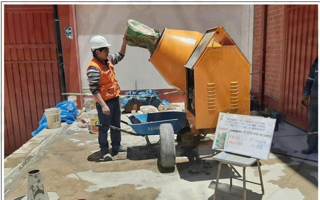
Figura A-08. Elaboración de muestras y especímenes de concreto utilizando cemento Nacional tipo I.
