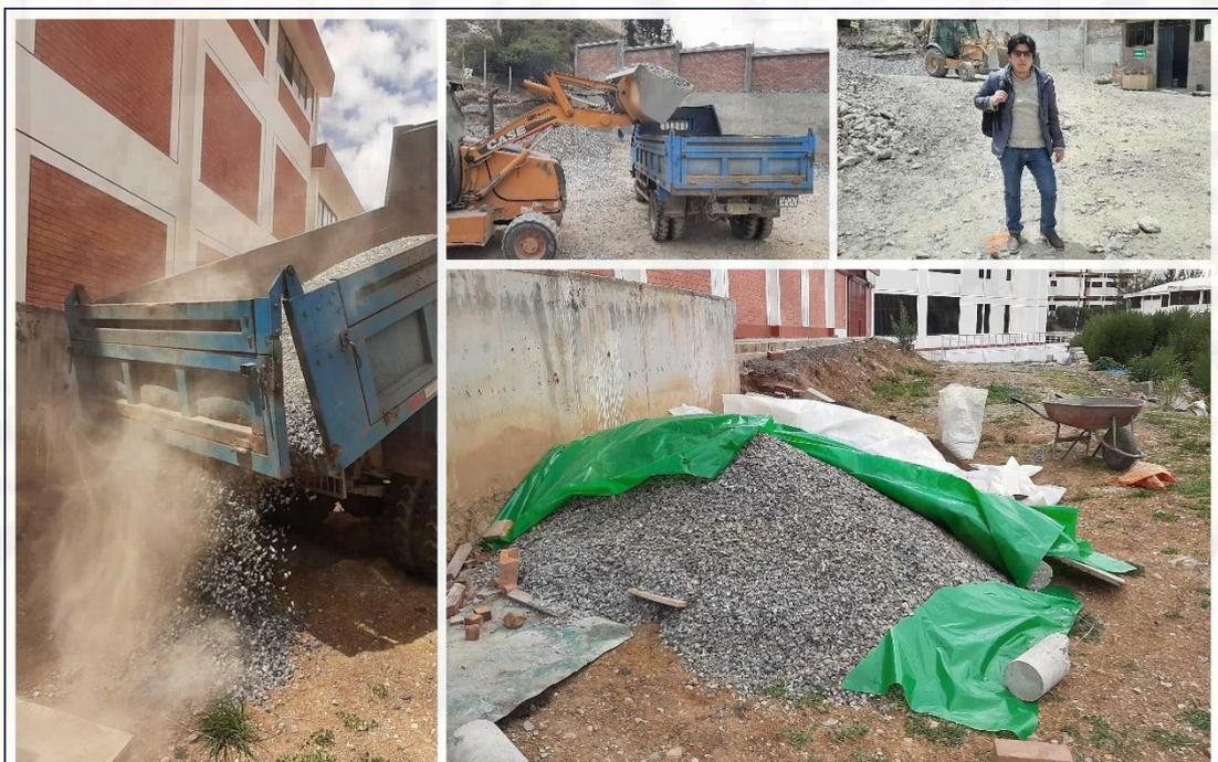
*Figura A-02. Muestreo, recepción y almacenamiento del agregado grueso.*
