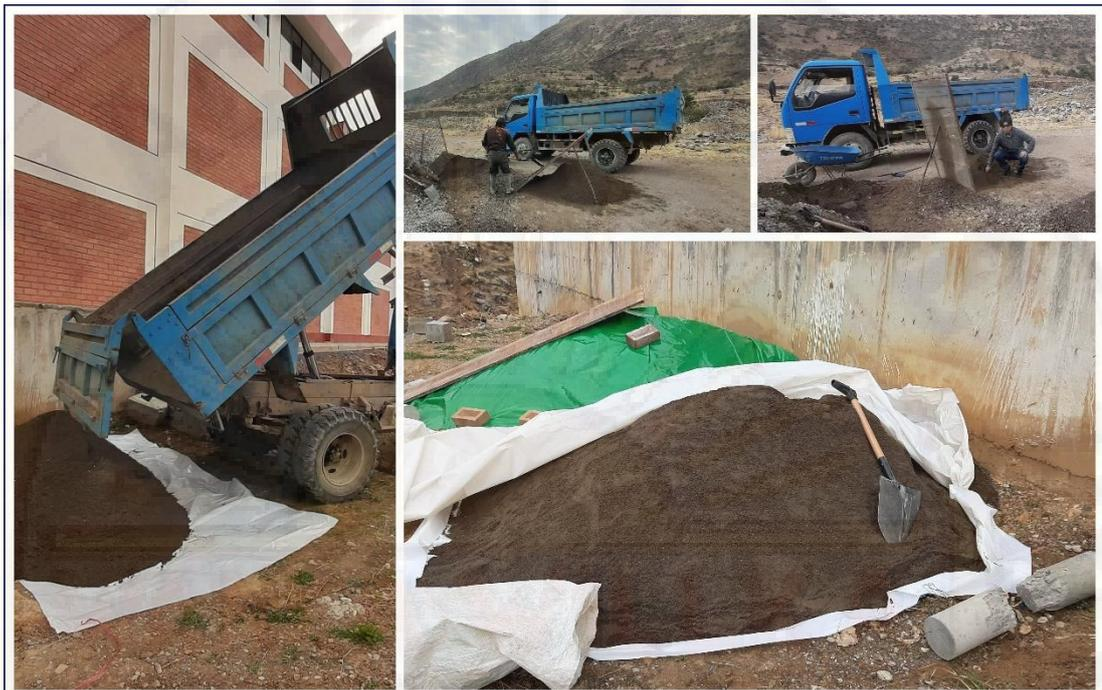
*Figura A-01. Muestreo, recepción y almacenamiento del agregado fino.*
