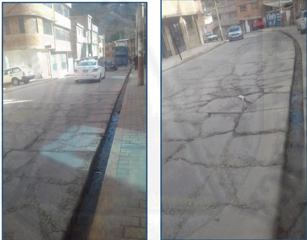
Figura 1.1 Vía deteriorada en av. Universitaria tramo Puente del ejército
