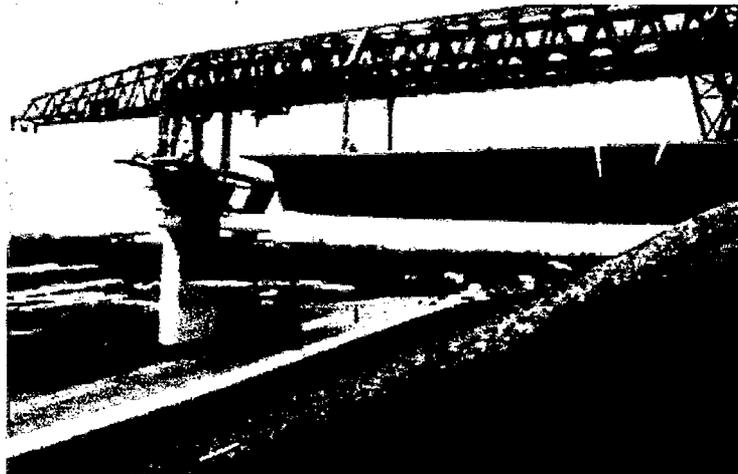
Figura 2.22. Construcción de un puente de dovelas con junta seca [CORVEN, 1993]
