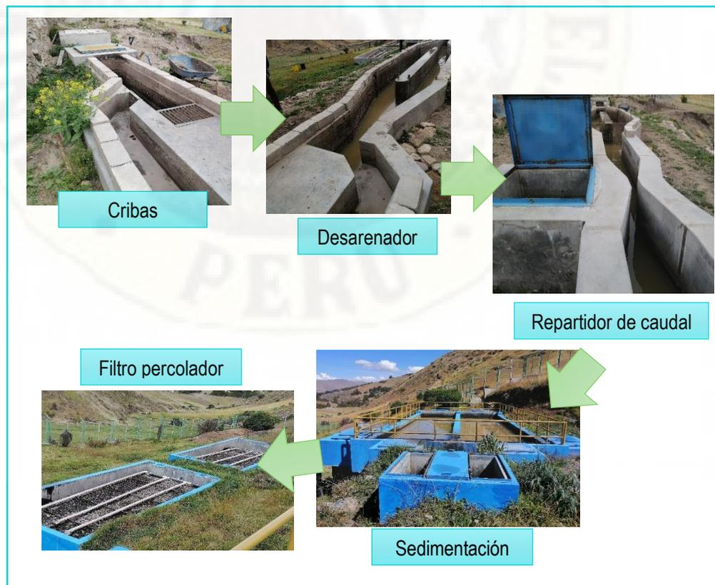
Para iniciar con la recolección de muestras de agua residual se realizó la ubicación de los puntos de muestro mediante un GPS – Etrex 20 en coordenadas UTM y en el sistema WGS84, la ubicación del P1 – afluente, es después de la caja de recolección de agua residual y antes del proceso de cribado, la ubicación del punto P2 – efluente es posterior al tratamiento secundario en el punto de vertimiento fuera de la PTAR como se muestra en la siguiente figura.
