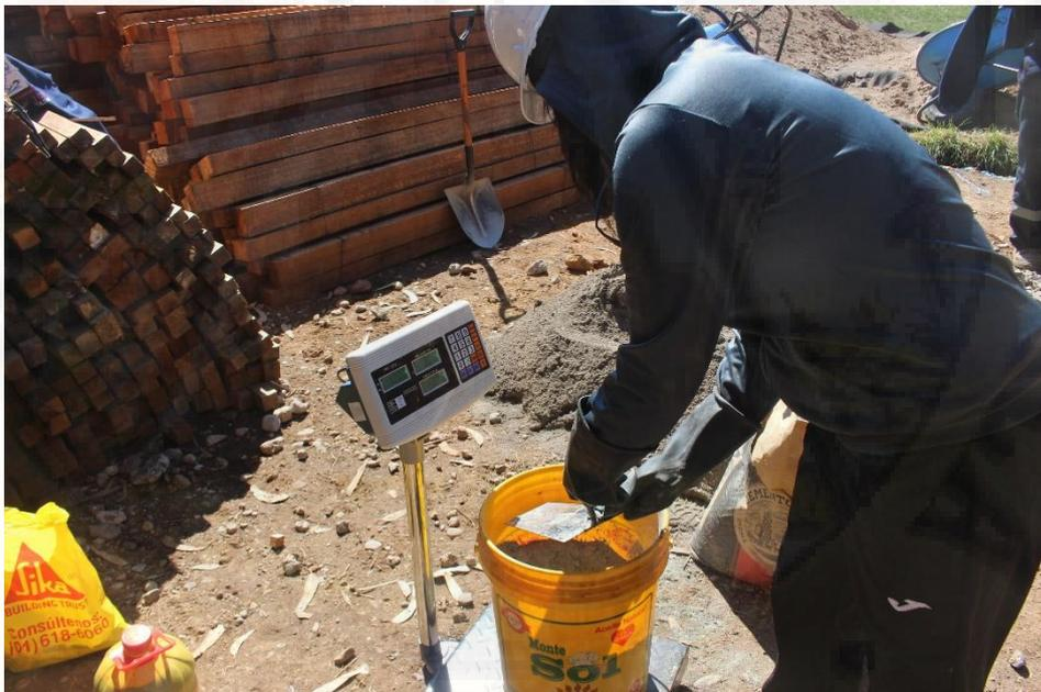
*Fotografía A 18. Selección de proporciones para el diseño de mezcla*
