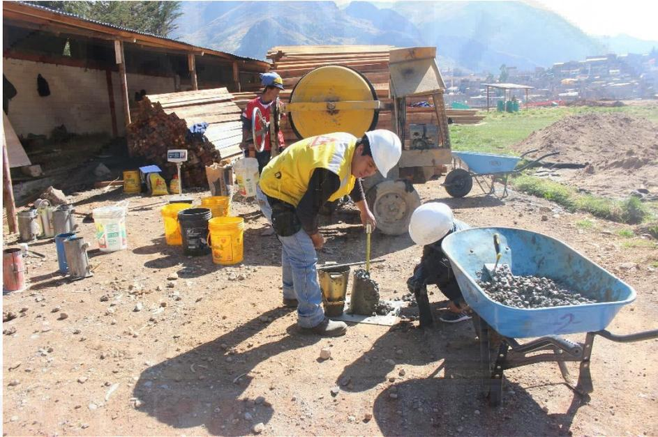
*Fotografía A 19. Verificación de slump para la comprobación de la trabajabilidad del diseño de mezcla*
