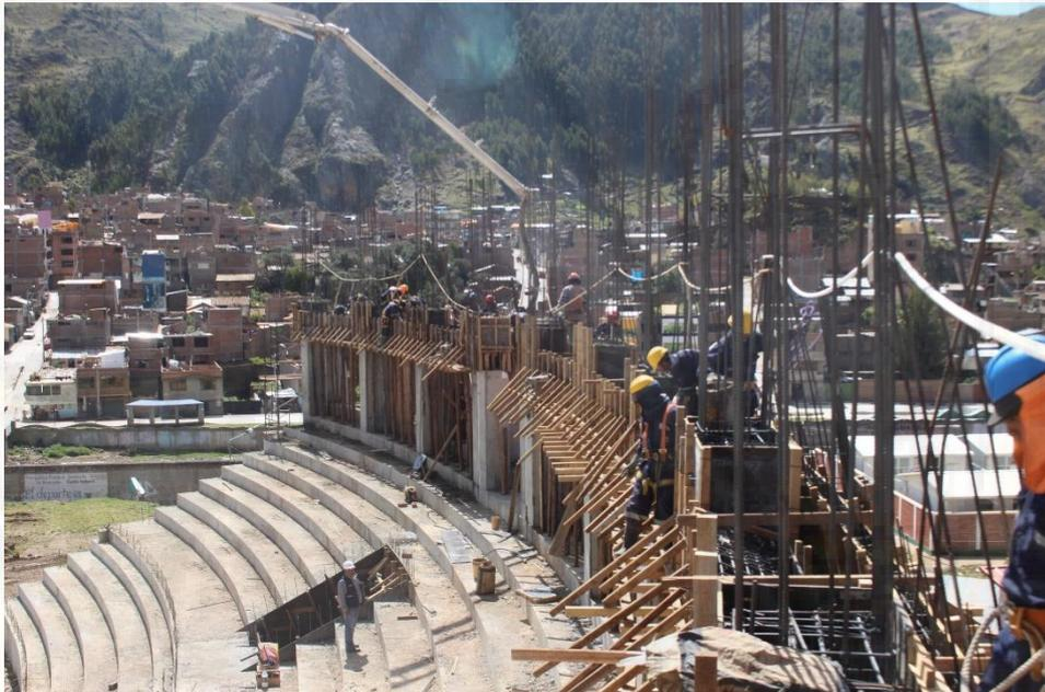
**Fotografía A 26.** Vaciado de vigas en la tribuna N°
