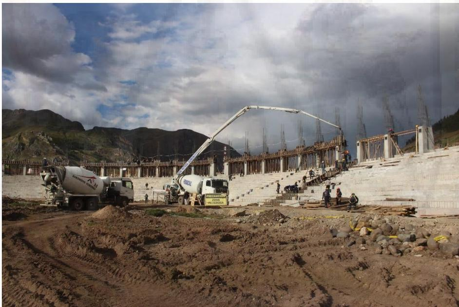
**Fotografía A 24.** Vaciado de columnas (cuarta etapa)
