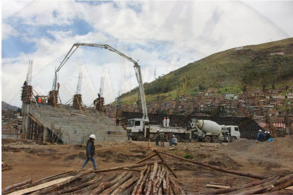
**Fotografía A 23.** Vaciado de columnas (tercera etapa)
