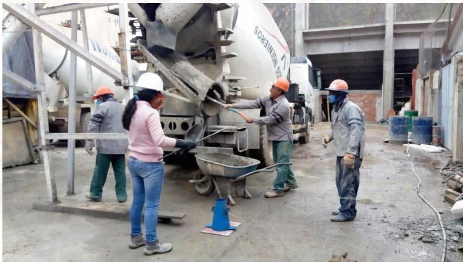
**Fotografía A 4.** Extracción de concreto del mixer para realizar las pruebas en estado fresco.
