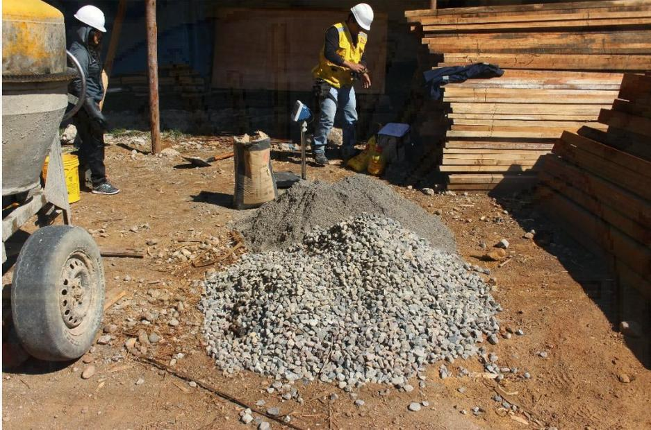
*Fotografía A 17. Selección de materiales para la comprobación de la trabajabilidad del diseño de mezcla*
