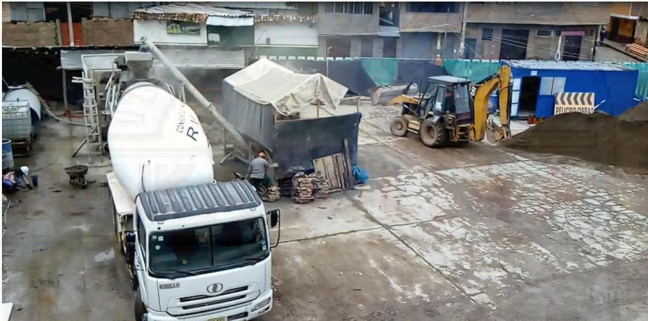
*Fotografía A 1. Dosificación de agregados*
