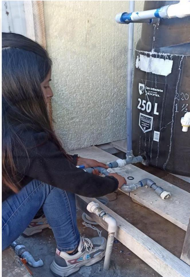
Cuarto paso: Sobre el techo del reservorio u plataforma preparada para la cloración, asegurar la colocación del tanque de solución clorada sobre una base adecuada y completar la instalación de suministro de agua. Con la abrazadera de derivación y una broca, tomar “un punto de agua en la línea de conducción, antes de la válvula de control”, para contar con agua que pueda facilitar la preparación de solución madre y el llenado del tanque de solución de acuerdo a los cálculos.
