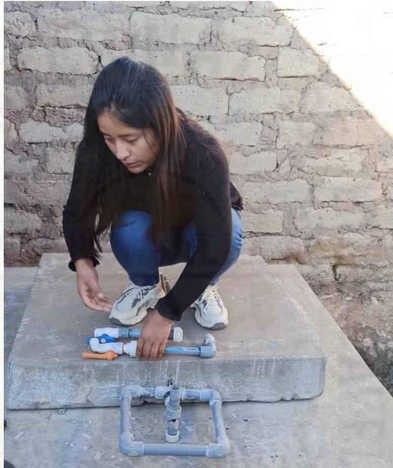
Segundo paso: Fabricar el soporte de la guía de nylon para el movimiento del flotador, adaptando al perfil interior del tanque de solución clorada que se disponga. Con la ayuda del hilo de nylon, colocar el flotador asegurando que en las diferentes posiciones del flotador la manguera siempre se encuentre extendida. Esta manguera debe quedar adherida a la placa de PVC que va en el intermedio de la unión universal junto al accesorio múltiple del tanque de solución clorada.
