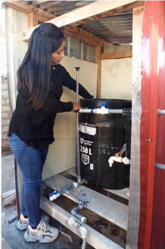
Paso 5: Llenar un poco de agua en el tanque de solución madre y regular el caudal de goteo.
