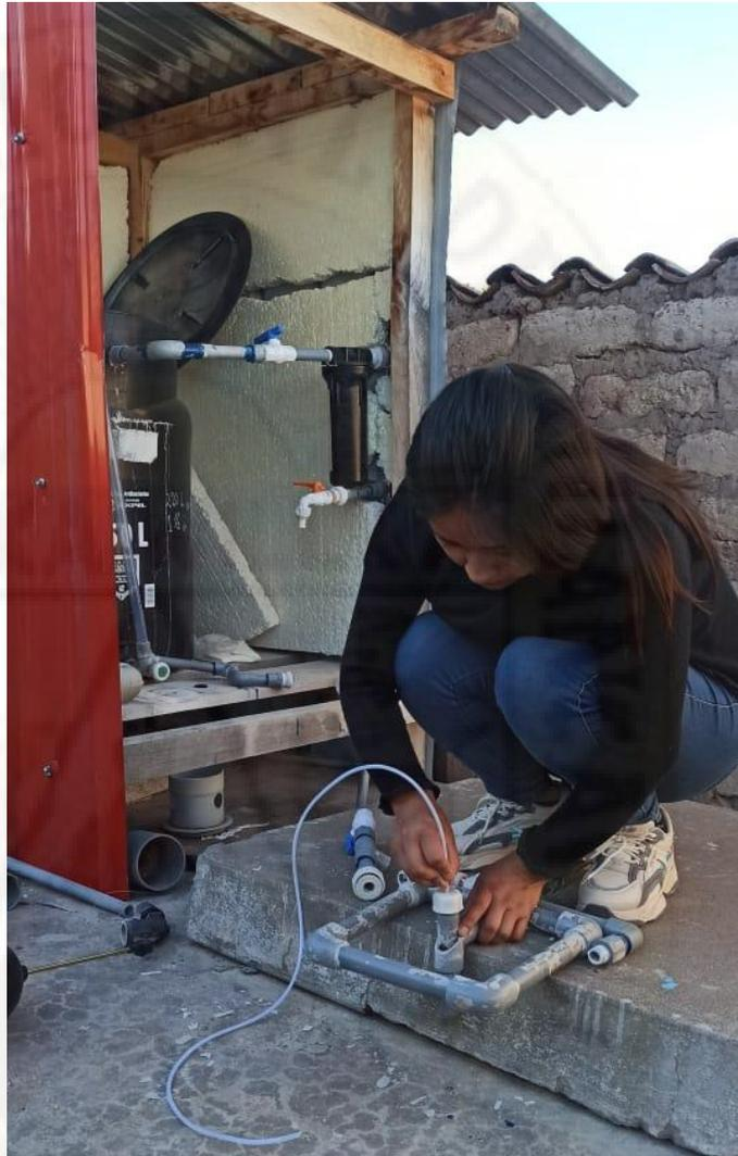
Tercer paso: "El accesorio múltiple del tanque de polietileno", colocar los demás accesorios: niples, tee y codos para disponer de un grifo de cálculo de caudal de goteo, válvulas de paso para la limpieza y para la tubería que va hacia el interior de reservorio. En el final del tubo conductor de solución clorada colocar la flotadora para impedir el ingreso de solución clorada cuando el reservorio se llene.
