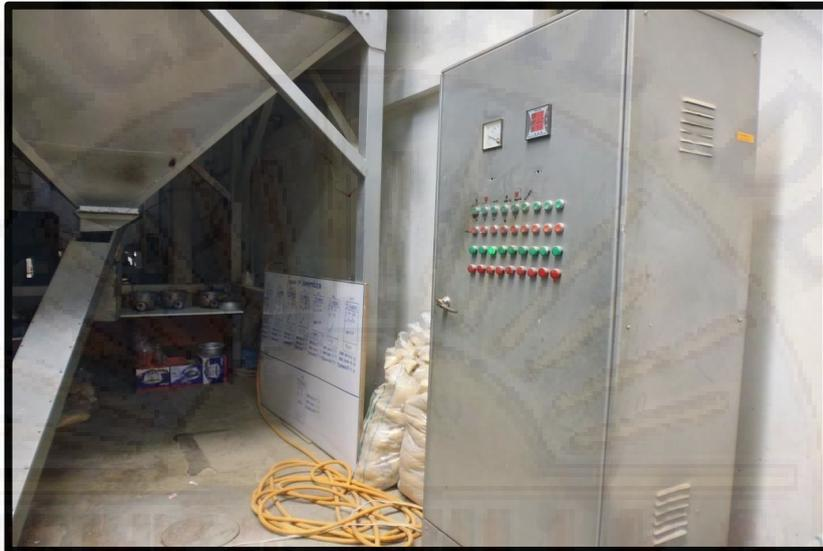
**Figura 10. Panel de control eléctrico sin señalización y cerca de comedor**
