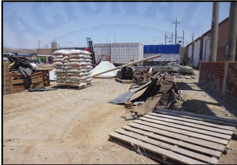
**Figura 12. Acopio sin señalización y en desorden**
