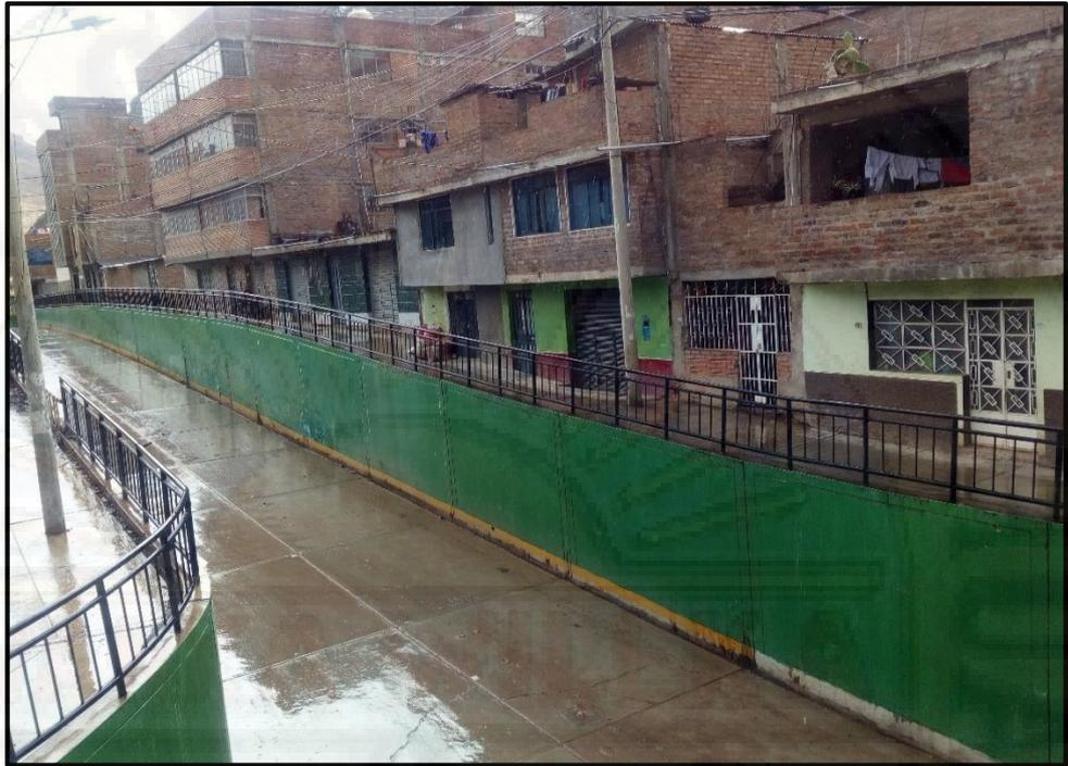
Fotografía 4. Muro pantalla de 72 metros de longitud y con de 18 paños.
