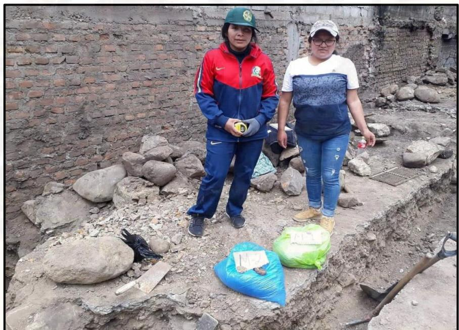
Fotografía 10. Obtención de muestras alteradas de las calicatas C-1 Y C-2
