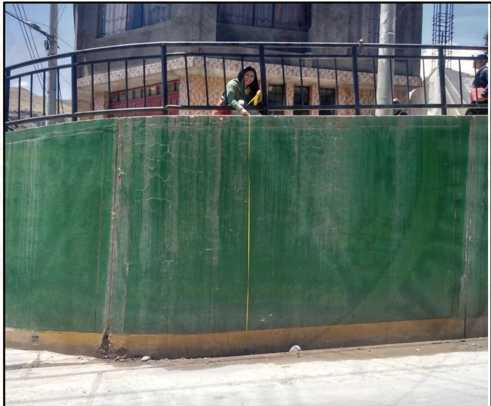
Fotografía 5. Medición de la altura del muro pantalla  $H=3.43$  m
