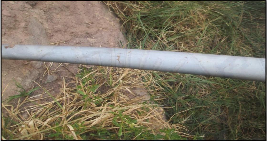
Fotografía N° 7: Línea de conducción descubierta.
