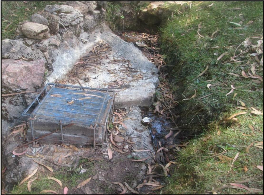
Fotografía N° 5: Cámara de Captación con una construcción inadecuada, se observa el lecho filtrante totalmente sellado no tiene una cámara de limpieza cuando presente obstrucciones del paso del agua a la cámara húmeda.
