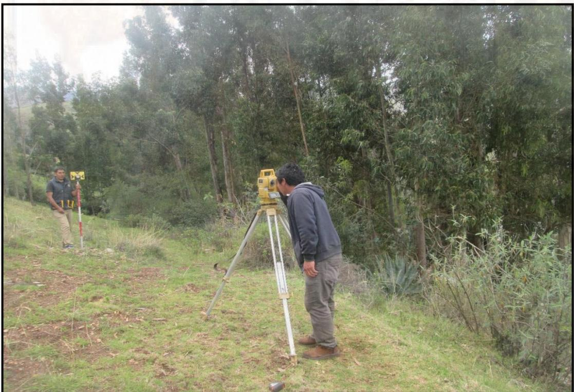
Fotografía N° 17: Levantamiento Topográfico de las líneas de conducción del sistema de Abastecimiento de Agua Potable.
