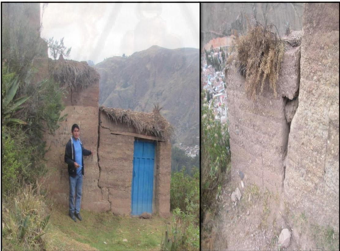
Fotografía N° 10: Cerco perimétrico del reservorio en malas condiciones.
