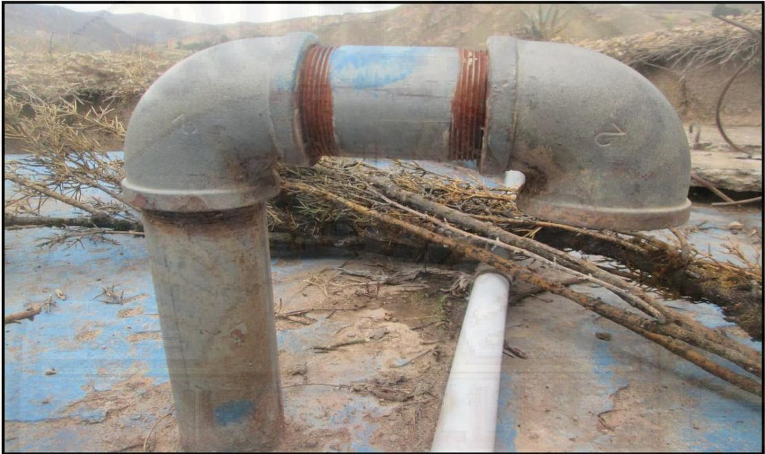
Fotografía N° 9: válvula de aire del reservorio en malas condiciones.
