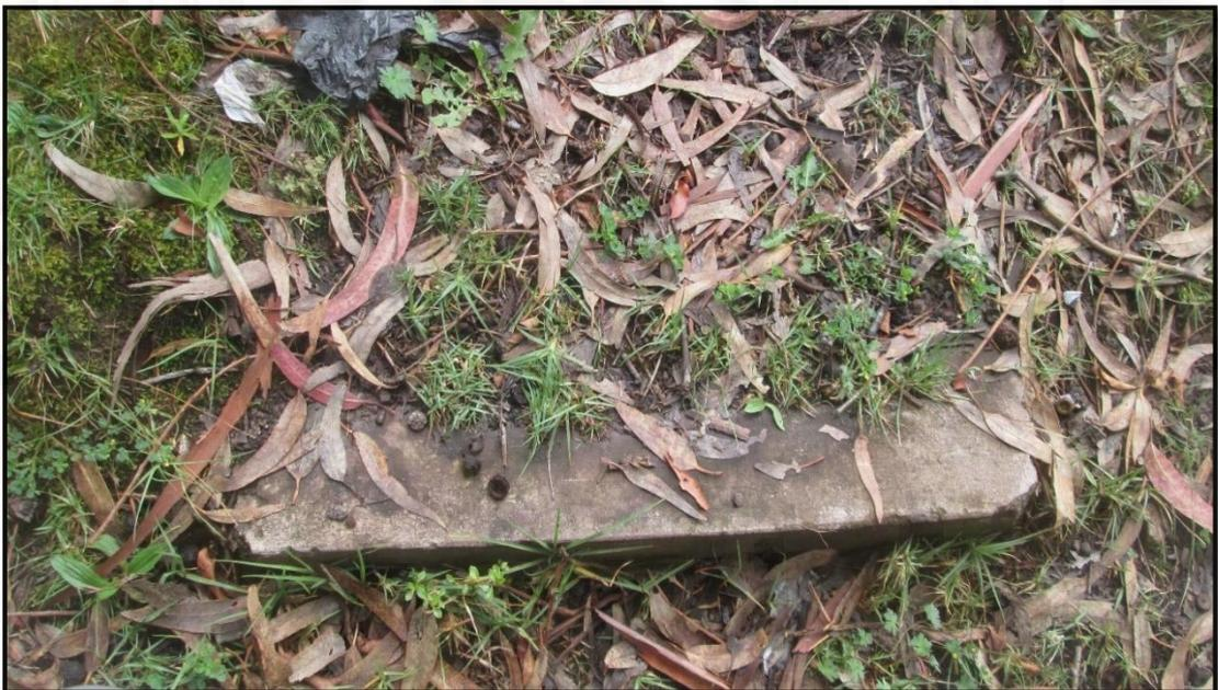
Fotografía N° 6: Cámara de Rompe Presión tipo CRP-6. Se encuentra enterrado obsoleto.
