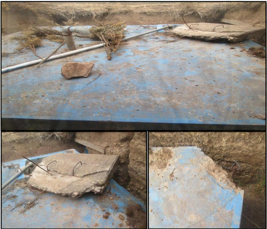
Fotografía N° 8: Reservorio de Almacenamiento de agua en malas condiciones.
