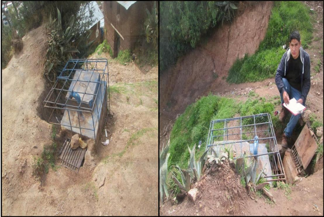
Fotografía N° 11: Cámara de Rompe presión tipo CRP-7 en malas condiciones.
