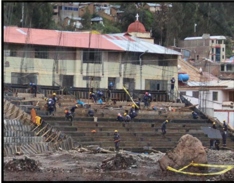
*Figura 2.2:* Encofrado en graderías
