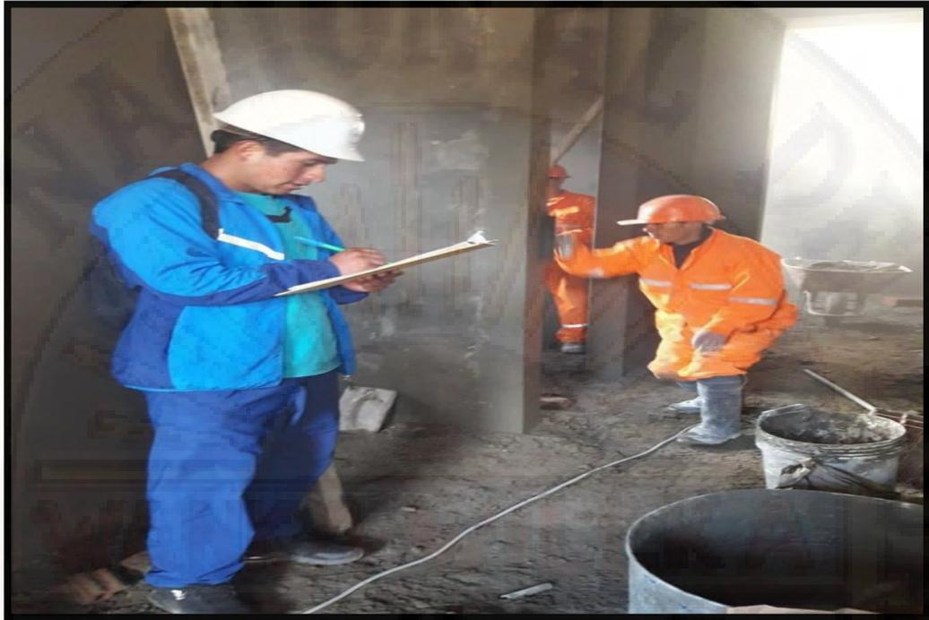
Fotografía 4: toma de datos del personal obrero en tarrajeo muro interior
