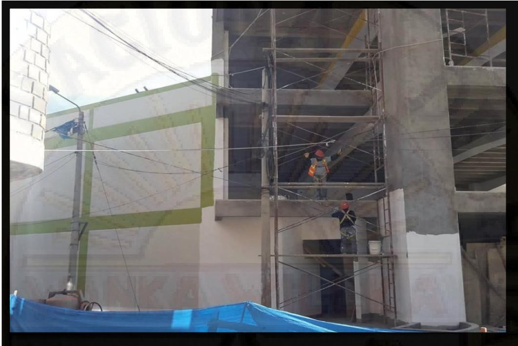
Fotografía 11: pintado de muro exterior con pintura c/ látex lavable
