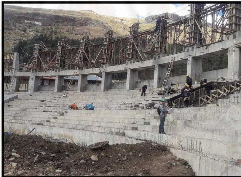
*Figura 2.3:* Encofrado en columnas
