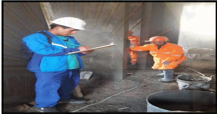
*Figura 2.4:* tarrajeo en muros interiores
