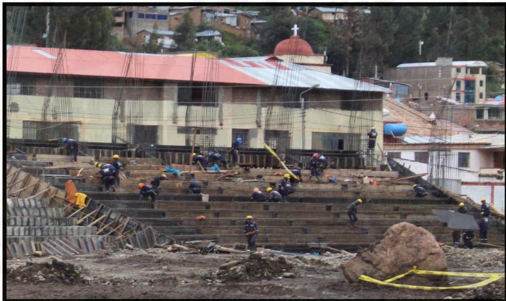
**Fotografía 2 : Encofrado de las graderías**
