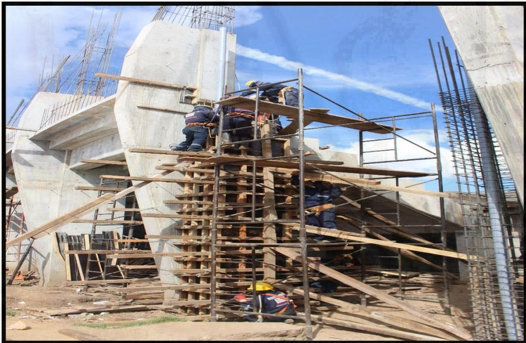
Fotografía 3 : Encofrado de las graderías y de columnas
