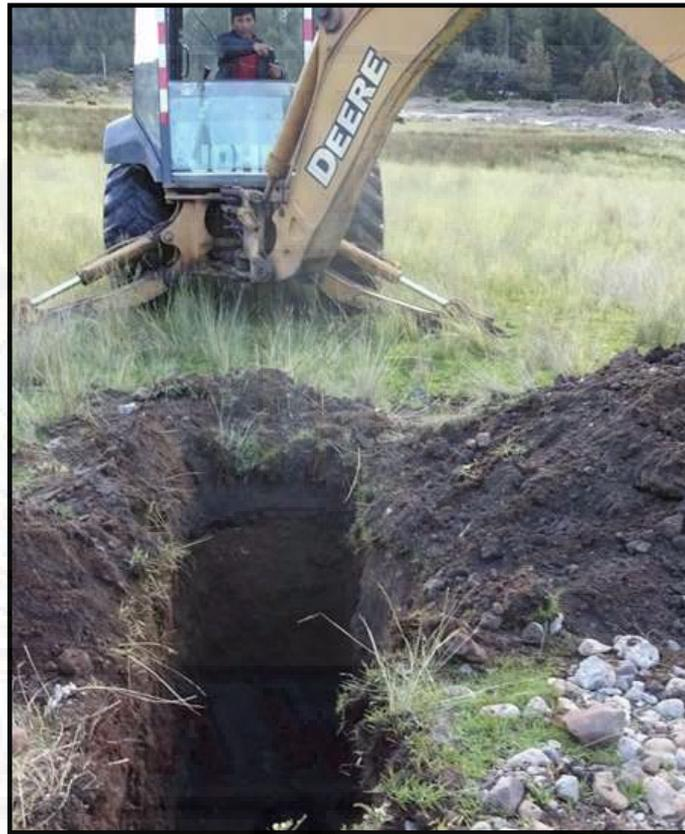
**Fotografía 20:** Excavación de calicata hasta una profundidad de 2.50 m.
