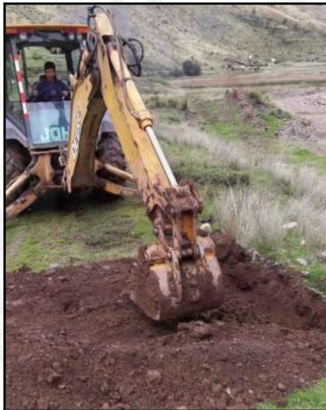
**Fotografía 19:** Excavación de calicata con el apoyo de una retroexcavadora.
