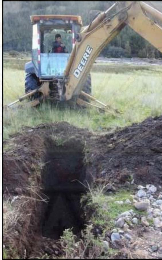
**Fotografía 1:** Excavación de calicata con retroexcavadora.
