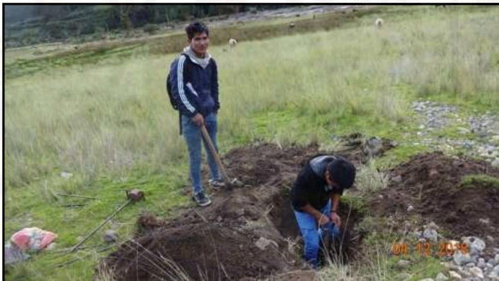
**Fotografía 23:** Se visualiza la excavación de calicata en forma manual.
