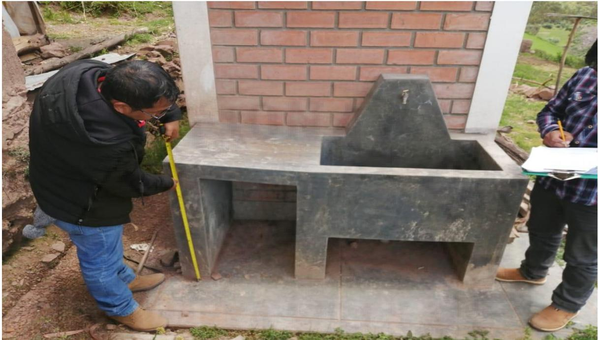
*Figura 87.* Investigadores constatando que las dimensiones de la UBS estén de acuerdo con las especificaciones técnicas estipuladas por el MVCS
