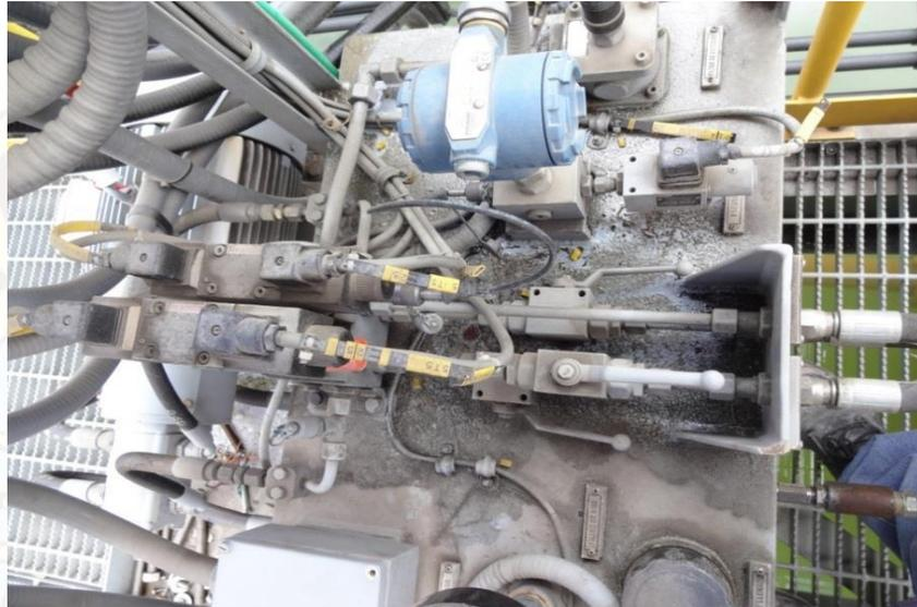
**Figura 2.9.** Switch de torque del tanque hidráulico de la rastra<sup>19</sup>
