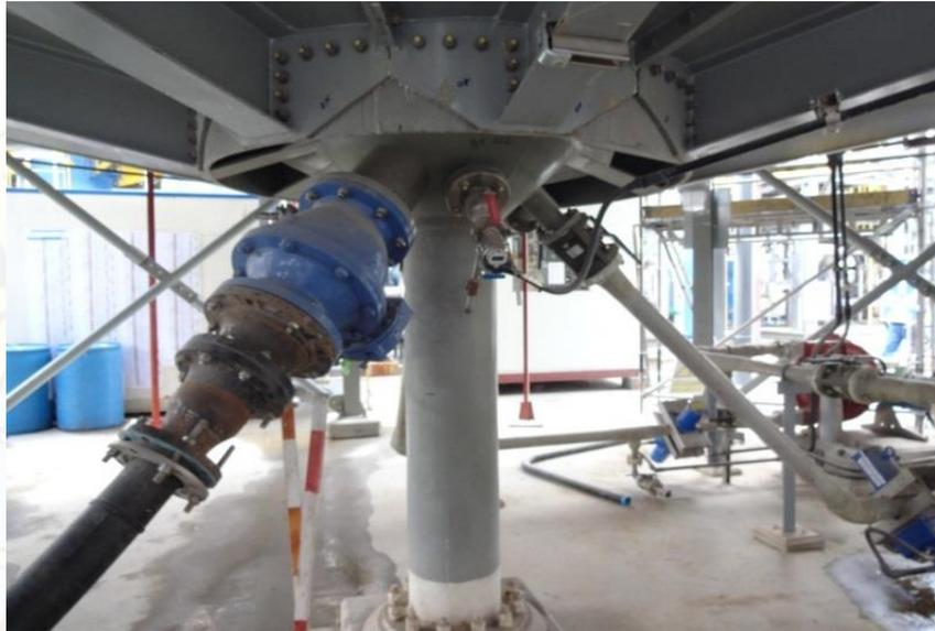
Figura 2.13. Transmisor de nivel de masa del espesador clarificador<sup>23</sup>
