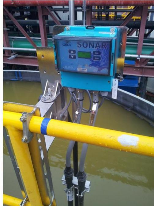
**Figura 2.12.** Medidor de nivel de cama del espesador clarificador<sup>22</sup>
