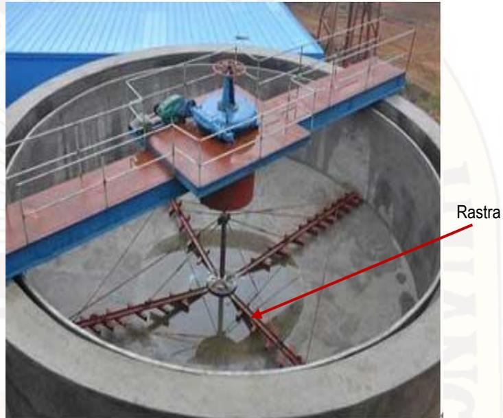
Figura 2.3. Rastra del espesador clarificador<sup>11</sup>
