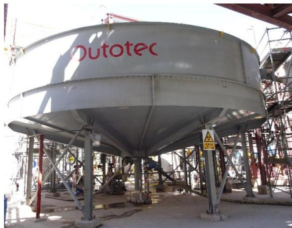
Figura 2.2. Tanque clarificador espesador<sup>10</sup>
