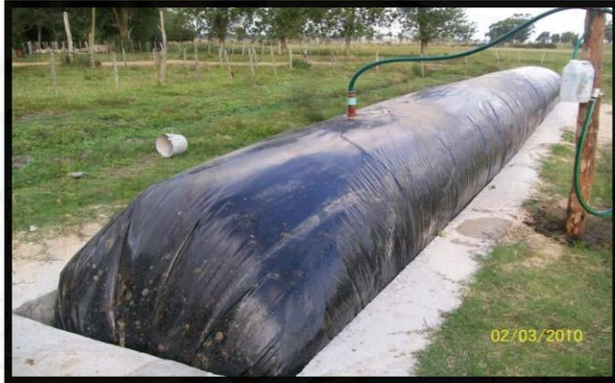
*Figura 2. Biodigester de flujo continuo.
