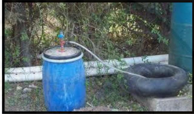
*Figura 6. Biodigestor de flujo discontinuo.
