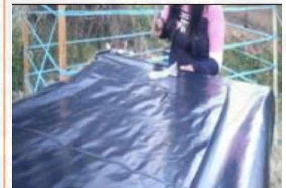
*Fotografía 20.* Se realizó el reforzamiento del forro luego que la temperatura no era constante ni adecuada para la producción de biogás.
