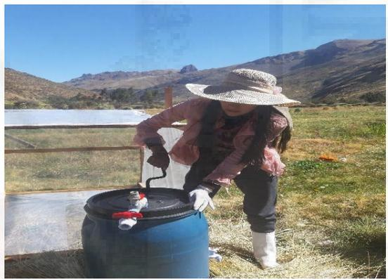
**Fotografía 25.** Se colocó 22.5 kg de excretas de bovino y se procedió al mezclado del sustrato dentro del biodigestor, contando con una mezcla homogénea.
