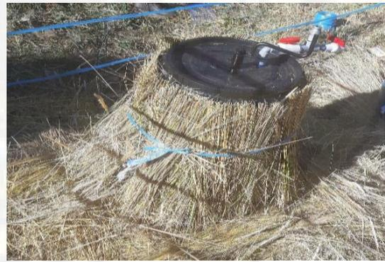
*Fotografía 23. Presentación de la cama de Ichu y cobertura alrededor del biodigestor, así mantuvo una temperatura interna adecuada para la producción de biogás.*
