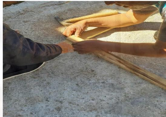
*Fotografía 16. Las uniones de la estructura se realizaron con clavos de 2 pulgadas, siendo esta firme y consistente.*
