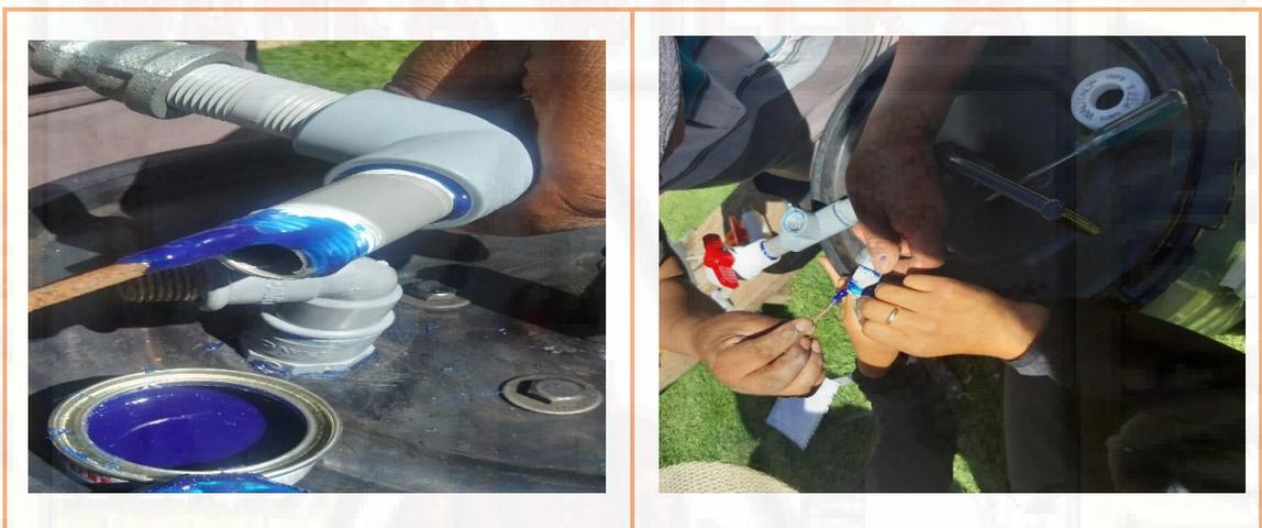
*Fotografía 10. Todas las uniones de los accesorios fueron hermetizadas con teflón y pegamento, evitando fugas durante todo el proceso de recolección de datos.*
