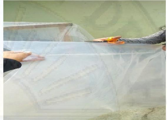
*Fotografía 18.* Se realizó el forrado de la estructura con plástico agrofilm de 6 m de largo y 1.5 m de ancho.
