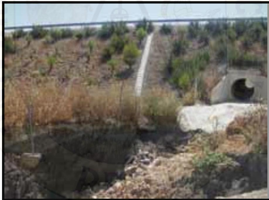
**Figura 10:** Cárcava iniciada por un desagüe de carretera mal finalizado.
