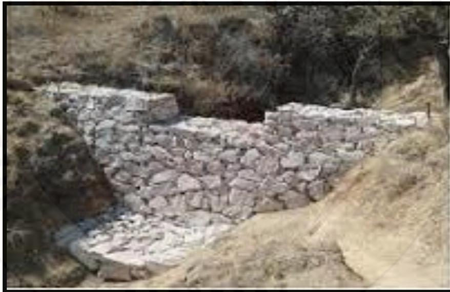
Figura 30: Impermeabilización en la disipación del aliviadero
