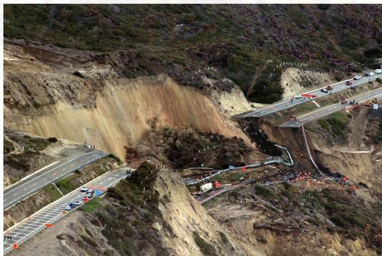
**Figura 03**, deslizamientos de plataformas de carreteras
