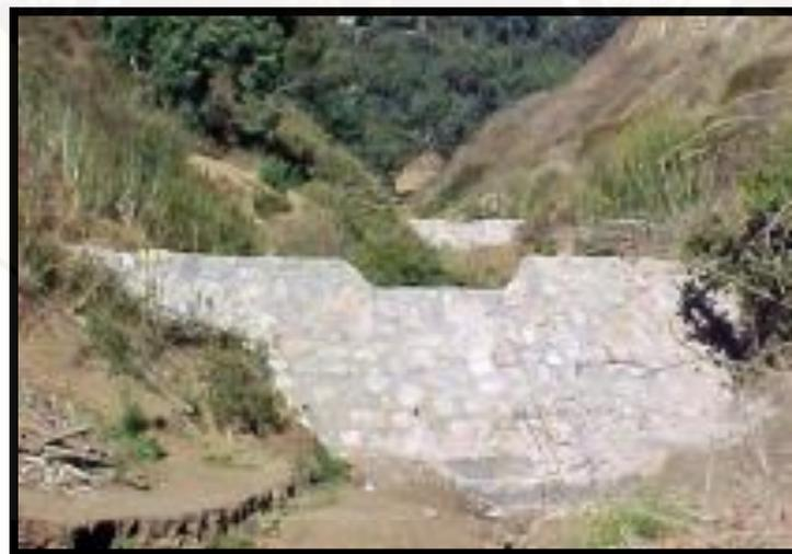
**Figura 28.** Diques construidos con cemento y piedra
