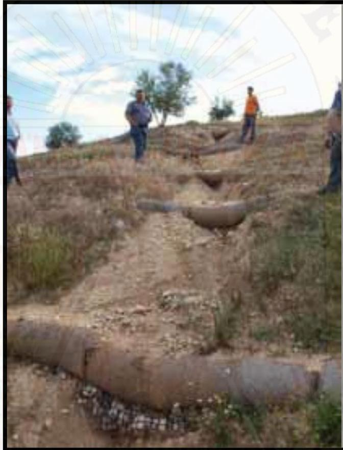
**Figura 26.** Pequeños diques de contención construida con gaviones flexibles de biorrollos.
