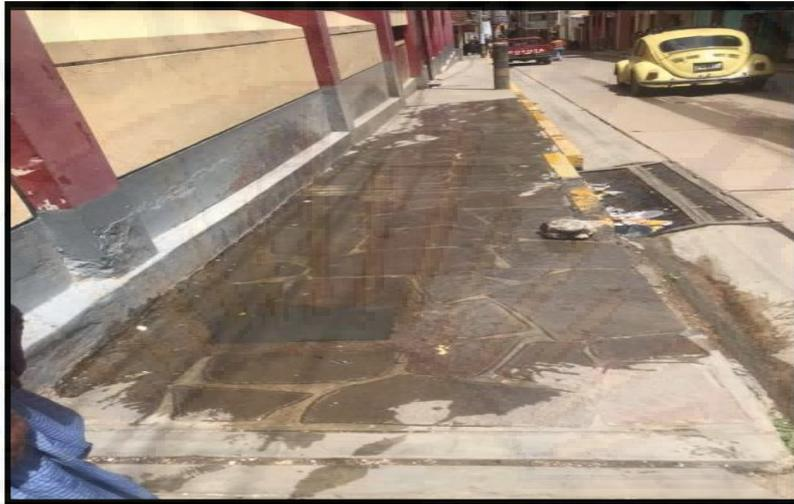
**Fotografía 37.** Fuga de la caja de registro de agua residual, esto ubicado en el Jr. Carabaya.
