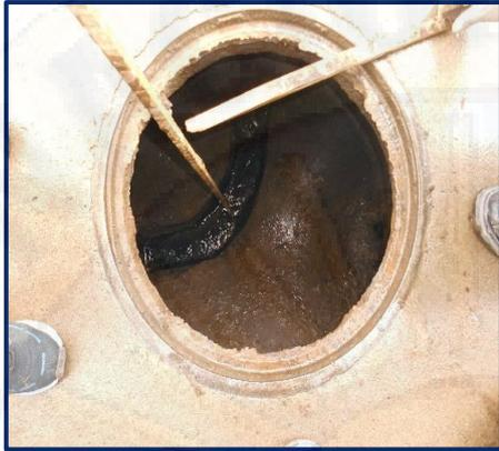
Buzón de diámetro de 1.20m y de profundidad de 1.30m, tubería de PVC de 8" de tapa hierro fundido, con una altura de agua del 75% del diámetro de tubería, se encuentra en estado operativo y está funcionando tal como su diseño.
