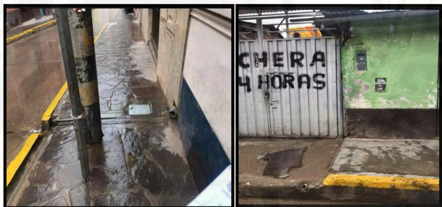
**Fotografía 32.** Tipos de montantes o tuberías por las que drenan la lluvia hacia las cunetas.
