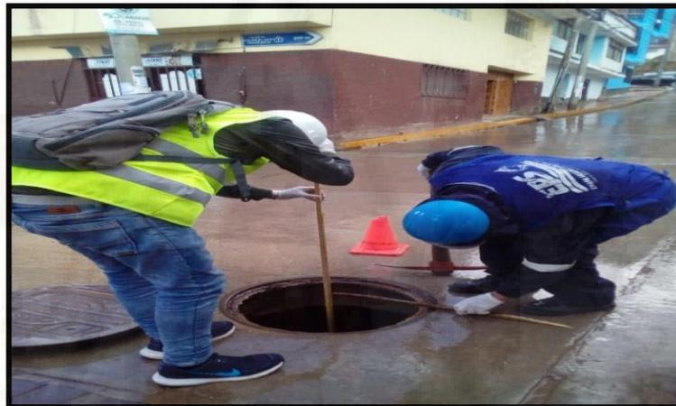
**Fotografía 19.** Medición de la altura del Buzón con la ayuda del personal de EMAPA, en el Jr. Torre Tagle.
