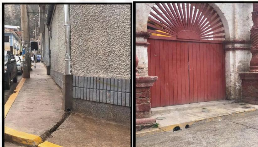
**Fotografía 29.** Tipos de montantes o tuberías por las que drenan la lluvia hacia las cunetas.
