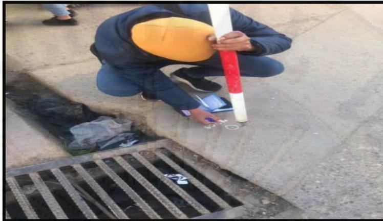
**Fotografía 10.** Levantamiento topográfico- ubicación de los puntos de estación.
