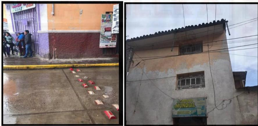
**Fotografía 31.** Tipos de montantes o tuberías por las que drenan la lluvia hacia las cunetas.
