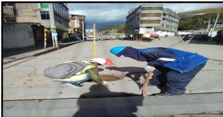
**Fotografía 21.** Apertura del Buzón en la intersección del Jr. Torre Tagle y Carabaya, siendo su estado del buzón muy antiguo y el diámetro de la interior es menor a la de la tapa.
