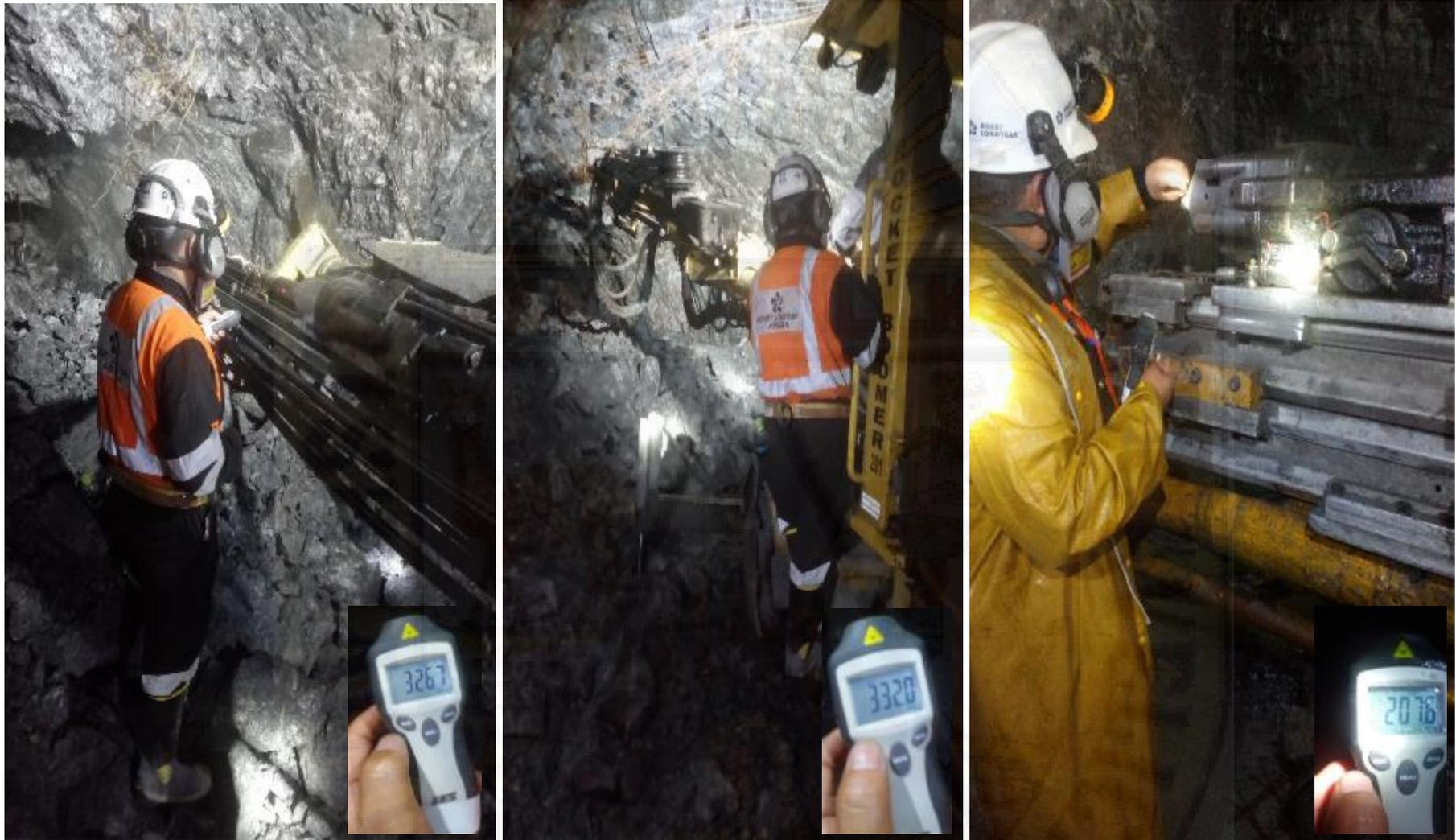
Fotografía 8. Monitoreo de las RPM y presiones de trabajo de los equipos de perforación Jumbo..
