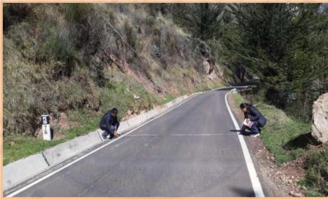
Figura N° 36: Hay podemos observar la métrica de calzada 3.70 m en la progresiva N°00+76,
