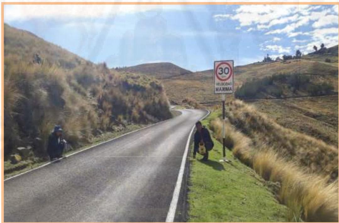
**Figura N° 51:** Hay podemos observar la métrica de calzada 3.70 m y la señalización
