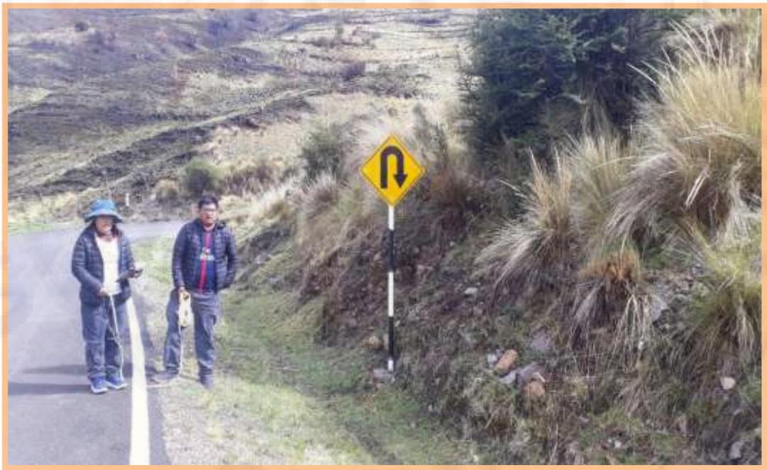
Figura N° 45: Hay podemos observar la métrica de calzada 3.70 m y berma de 0.80 m. y la señalización.
