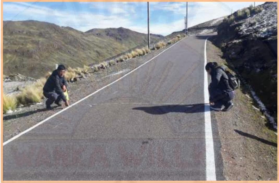
**Figura N° 78:** Hay podemos observar la métrica de calzada 3.80 m.
