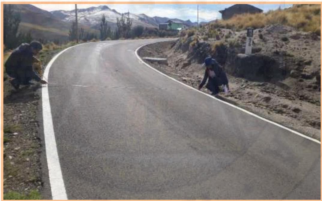
**Figura N° 55:** Hay podemos observar la métrica de calzada 3.70 m en la progresiva N°00+96,
