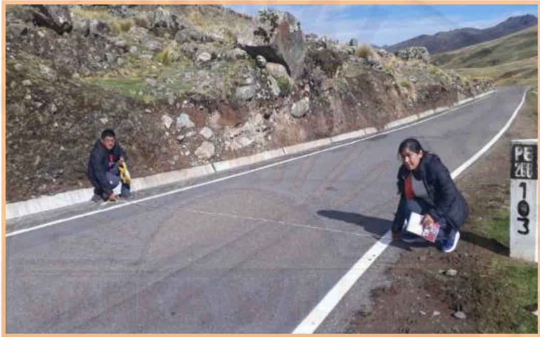
**Figura N° 64:** Hay podemos observar la métrica de calzada 3.90 m en la progresiva N°00+103, con berma de 1.20 m, con la cuneta de 1.00 m y altura de 0.50m
