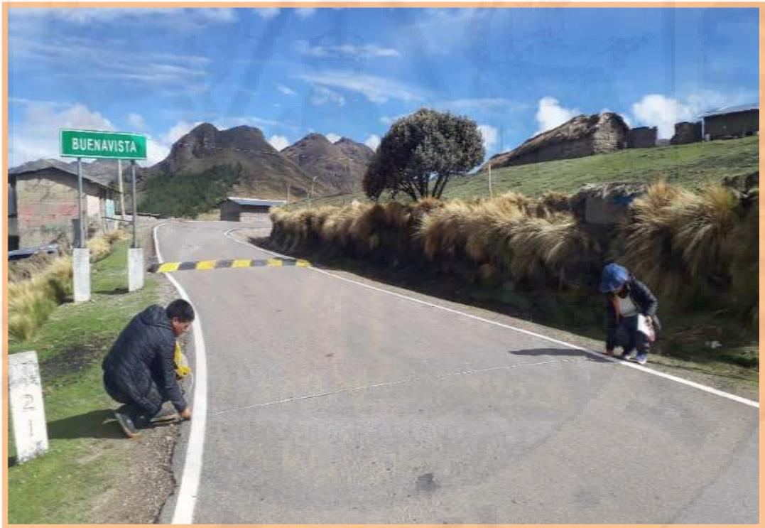
**Figura N° 53:** Hay podemos observar la métrica de calzada 4.00 m en la progresiva N°00+95, y la señalización
