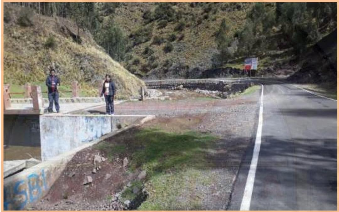
Figura N° 42: Hay podemos observar la métrica de calzada 3.70 m
