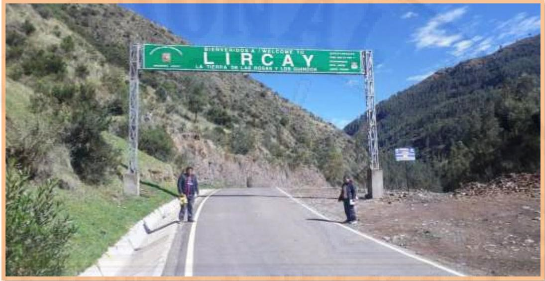
Figura N° 37: Hay podemos observar la métrica de calzada 3.70 m en la progresiva N°76, con berma de 0.80 m, con la cuneta de 1.30 m y altura de 0.50m
