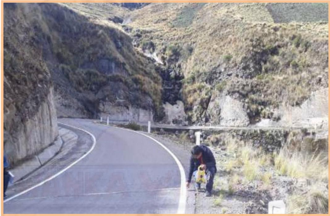
**Figura N° 56:** Hay podemos observar la métrica de calzada 3.70 m en la progresiva N°00+100, con berma de 0.80 m, con la cuneta de 1.30 m y altura de 0.50m
