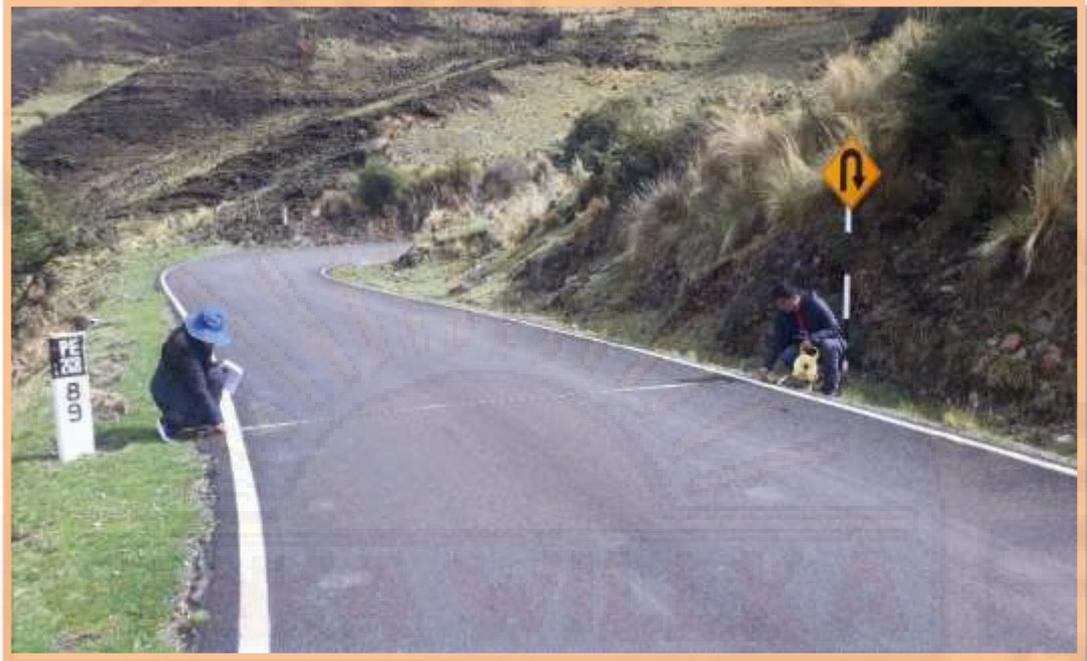
Figura N° 46: Hay podemos observar la métrica de calzada 4.50 m en la progresiva N°00+89, con su respectiva señalización
