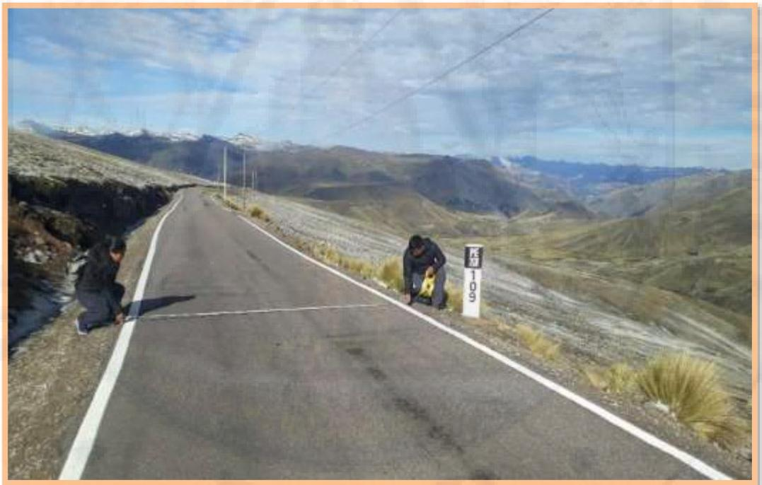
**Figura N° 77:** Hay podemos observar la métrica de calzada 3.80 m en la progresiva N°109.
