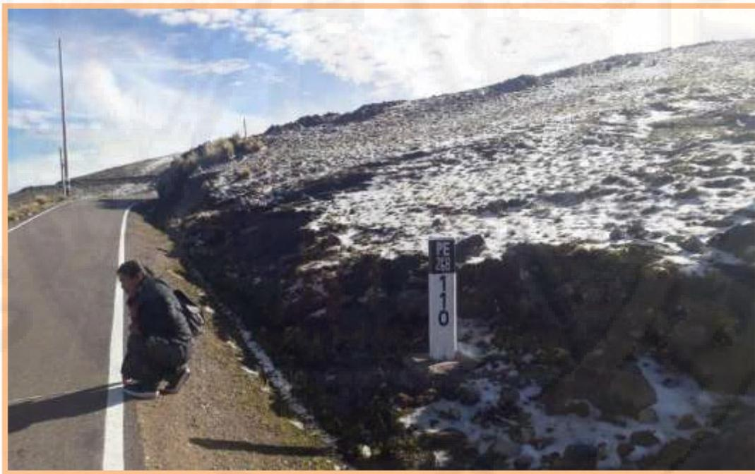
**Figura N° 79:** Hay podemos observar la métrica de calzada 3.80 m en la progresiva N°00+110.
