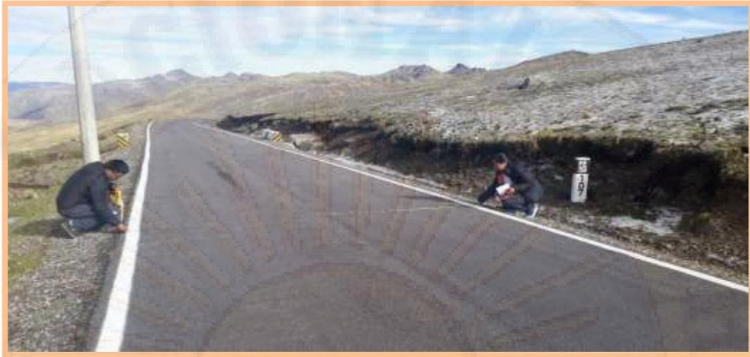
**Figura N° 74:** Hay podemos observar la métrica de calzada 3.80 m en la progresiva N°00+107, con berma de 0.80 m.
