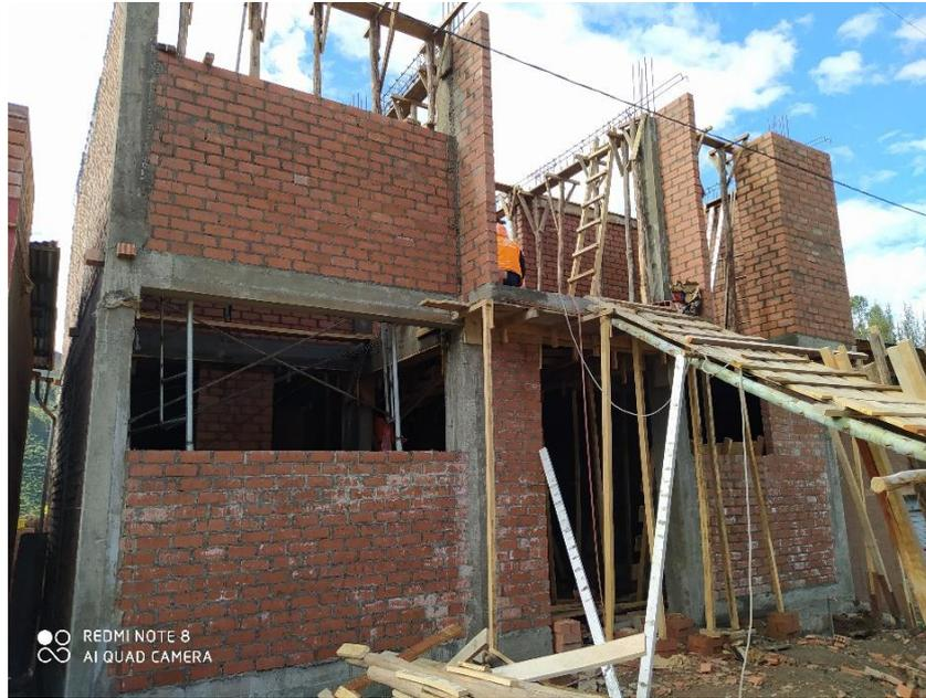
FOTO N°14: ARMADO DE LAS VIGAS DEL SEGUNDO PISO
