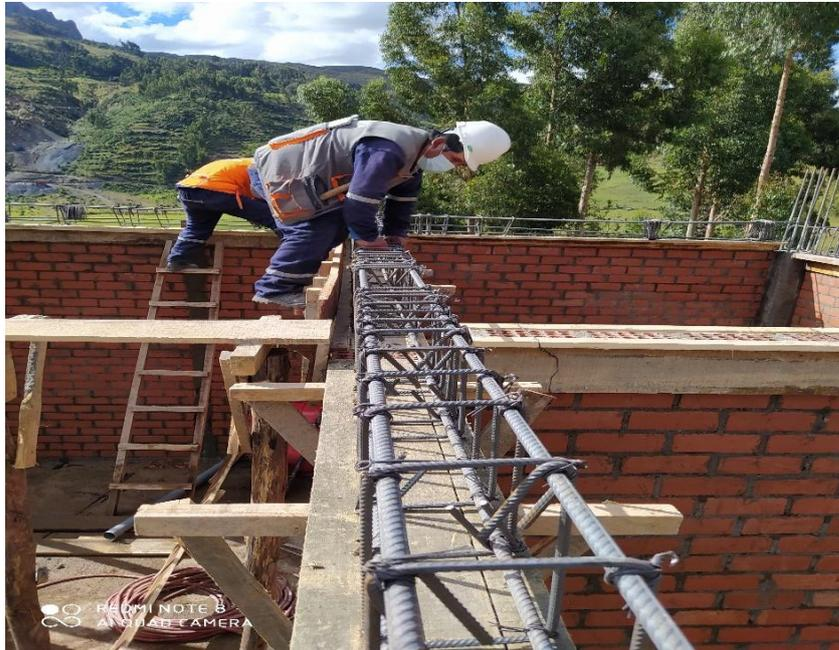
FOTO N° 16: SE OBSERVA EL ENCOFRADO DE LAS VIGAS DEL SEGUNDO PISO.
