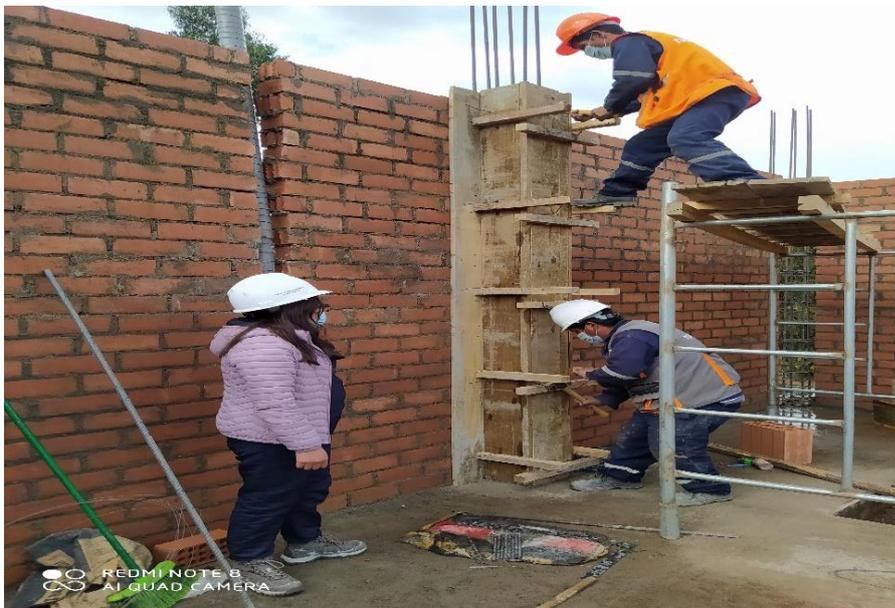
FOTO N°11: VERIFICACIÓN DEL PLANO PARA EL ARMADO DE LAS COLUMNAS Y VIGAS DEL SEGUNDO PISO
