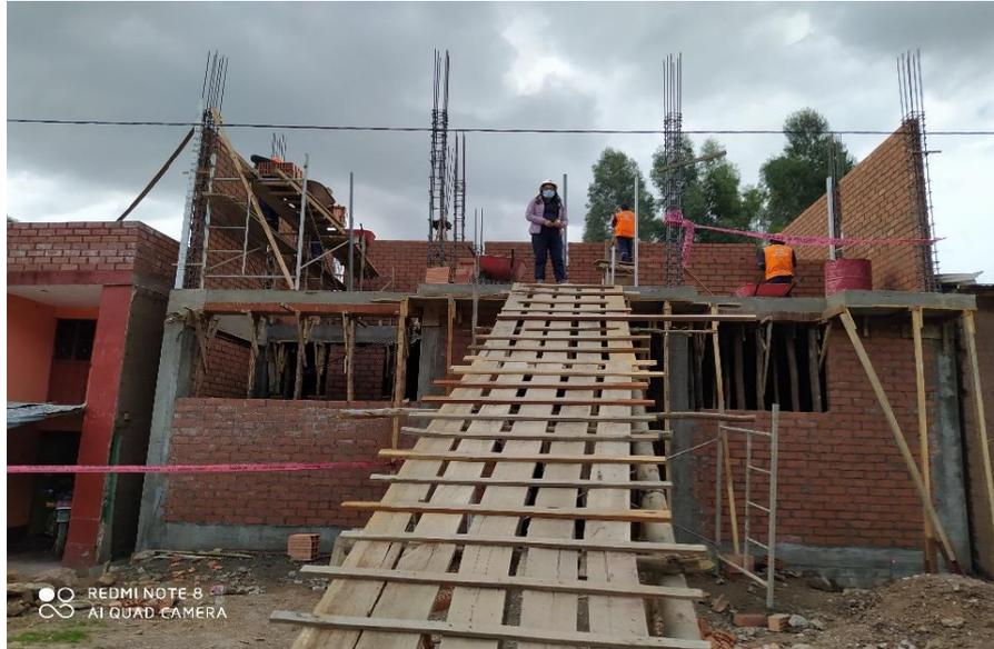
FOTO N°10: SE MUESTRA EL DESENCOFRADO DE LAS COLUMNAS YVIGAS Y DE LA PRIMERA PLANTA.
