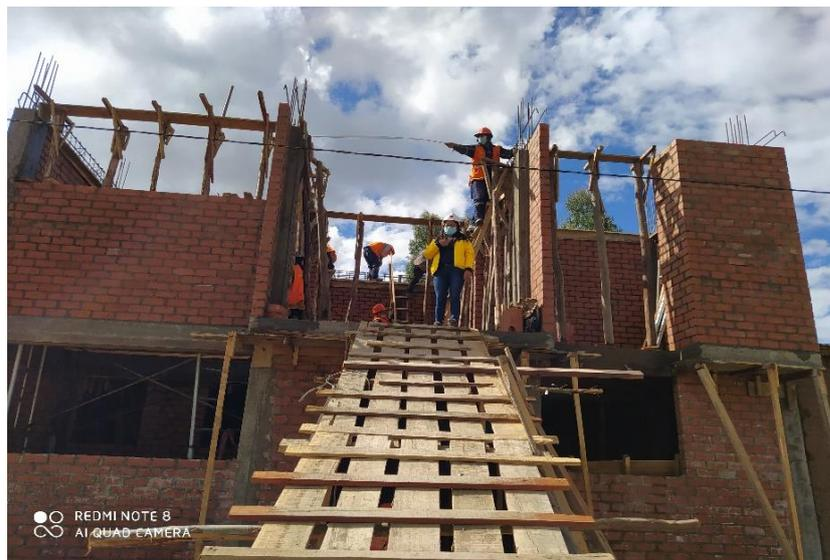
FOTO N°15: ARMADO DE ACERO PARA LAS VIGAS.
