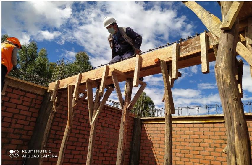
FOTO N°17: SE OBSERVA LAS VIGAS Y VIGUETAS DEL SEGUNDO NIVEL
