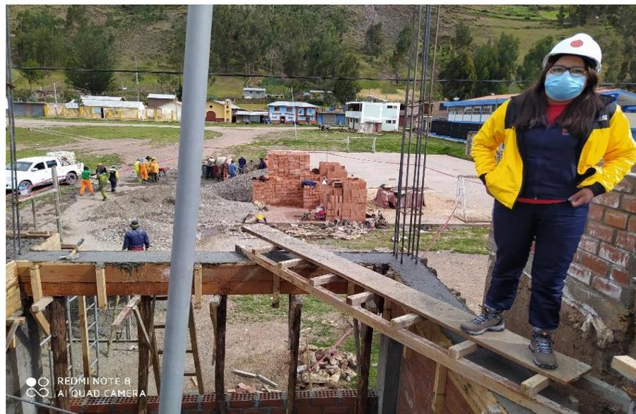
FOTO N° 7: SE OBSERVA LAS COLUMNAS DE LA PRIMERA PLANTA Y EL ENCOFRADO DE LAS VIGAS Y SU RESPECTIVO VACIADO DEL TECHO.
