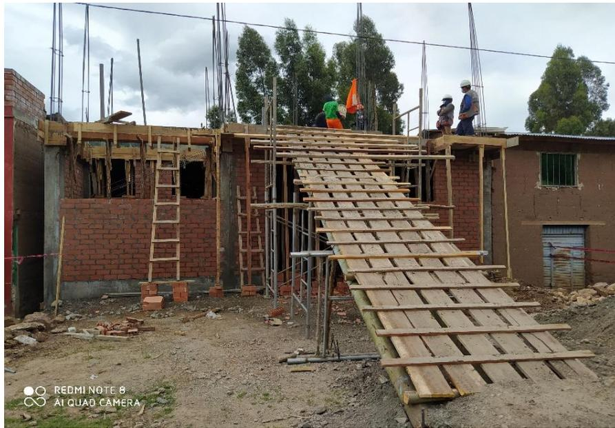
FOTO N°08: SE MUESTRA EL ARMADO Y VACIADO DEL TECHO.
