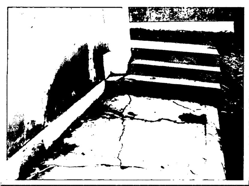
**Fotografía N° 08:** Vista de las fallas ocasionadas por la acción de las aguas subterráneas dadas en la I.E. América
