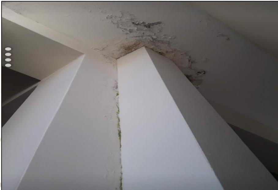
*FIGURA 3. Deterioro de paredes y techos por la humedad.*
