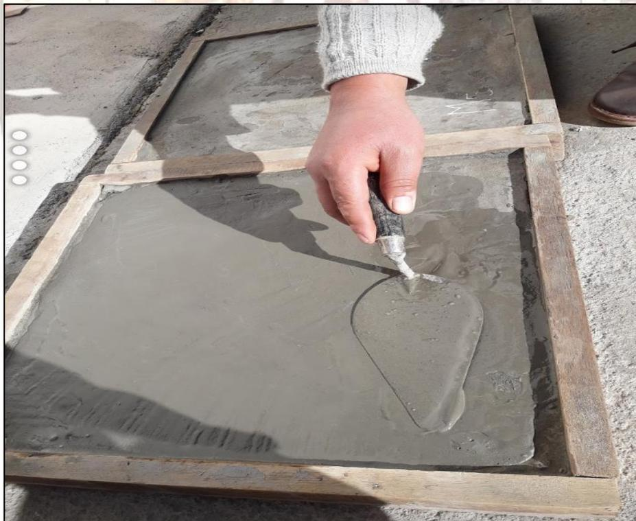
*FIGURA 44. Aplicación del impermeabilizante.*
