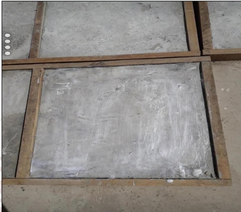
*FIGURA 25. Aplicación de la primera capa del impermeabilizante realizado.*
