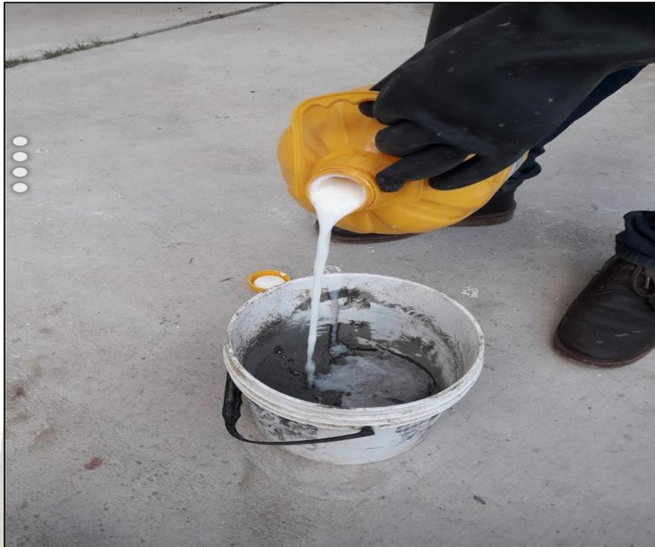
*FIGURA 47. Aplicación del impermeabilizante Sika.*
