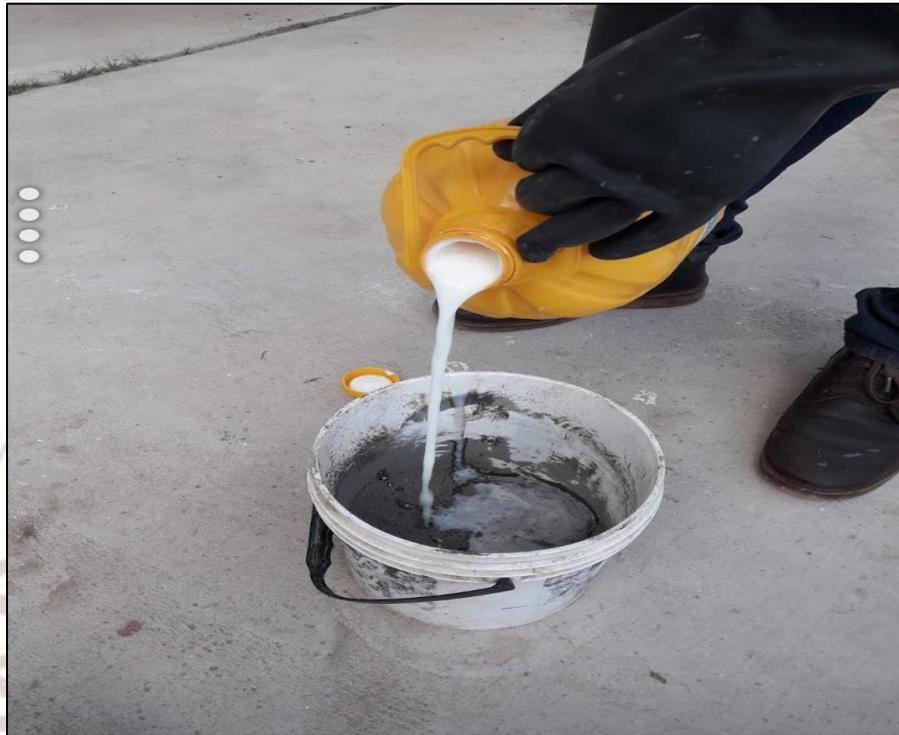
*FIGURA 22. Mezclado del impermeabilizante comercial Sika antes de su aplicación.*
