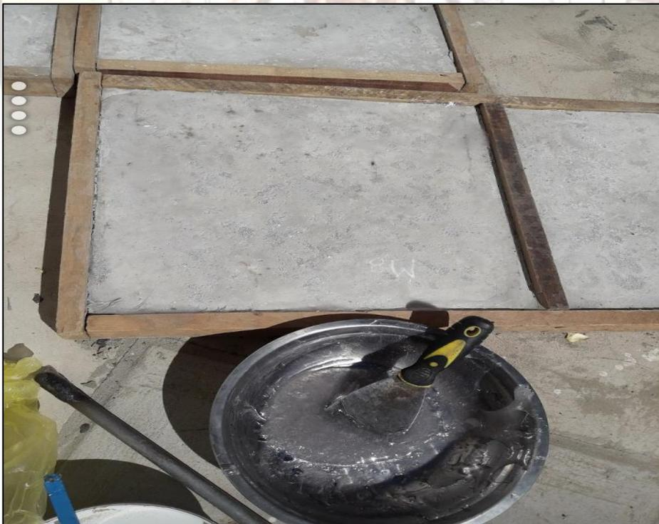
*FIGURA 42. Impermeabilizante listo para ser aplicado.*
