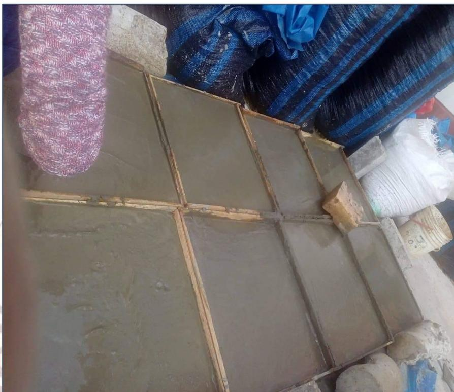
*FIGURA 7. Vaciado de probetas.*
