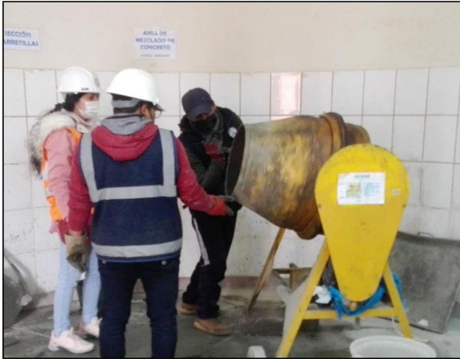
Figura 62. Proceso de mezclado del cemento, piedra partida, arena gruesa y agua
