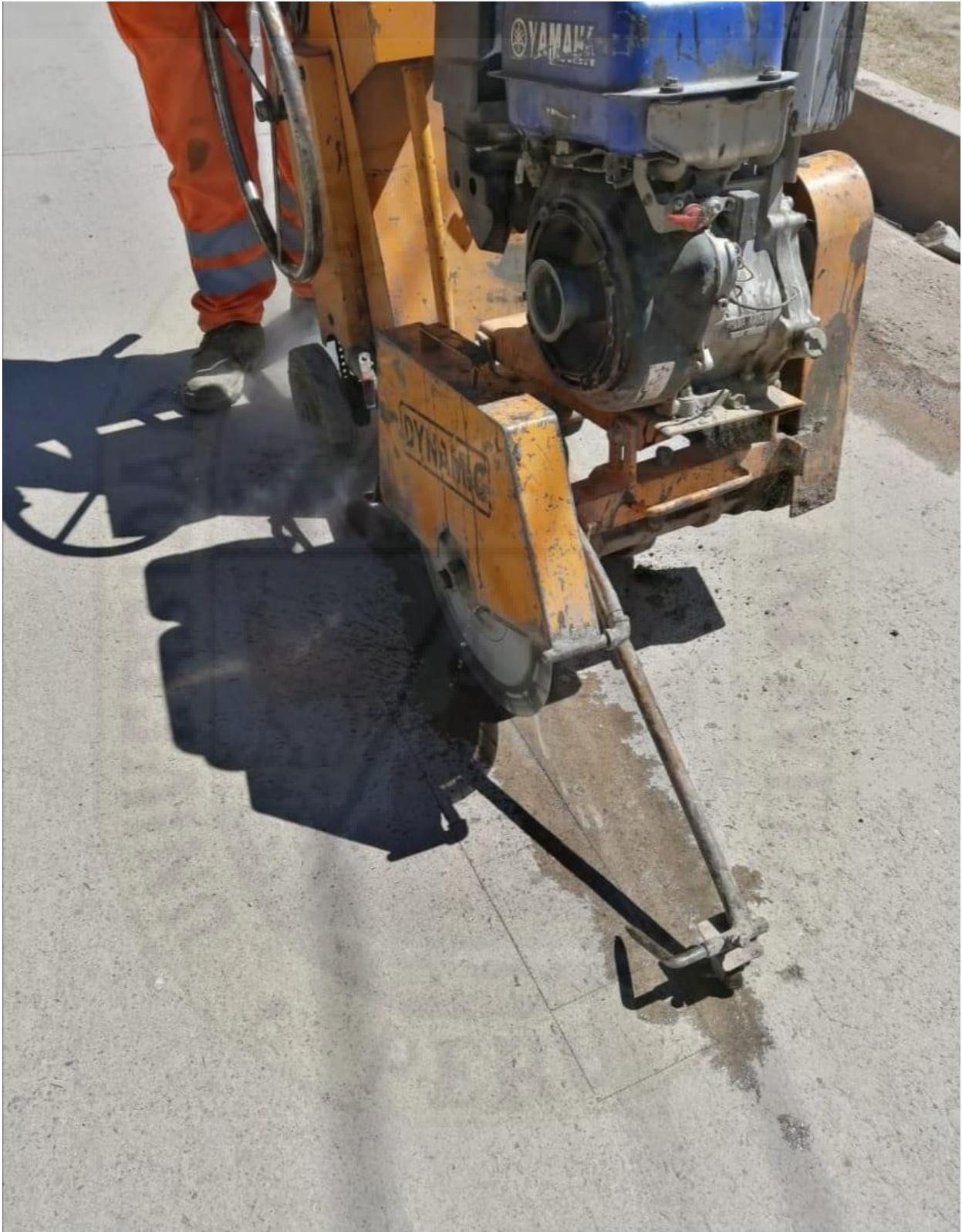
**Panel Fotográfico:** Preparación para extracción de muestra
