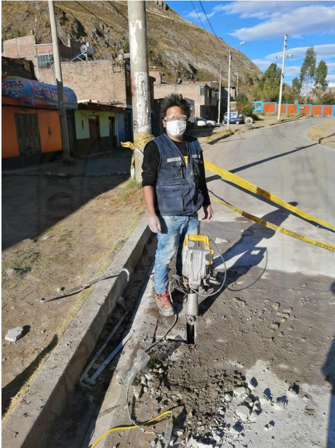
**Panel Fotográfico:** Extracción y Corte de Muestras de pavimento.
