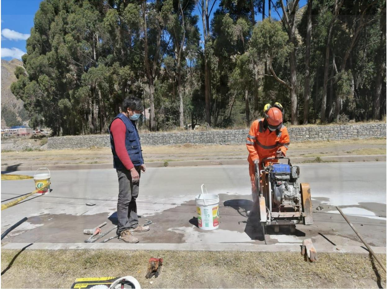
**Panel Fotográfico:** Extracción y Corte de Muestras de pavimento.
