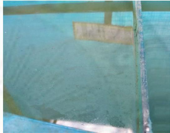
*Figura 43. Retención de aceites y grasas en el pretratamiento y tratamiento primario del sistema.*
