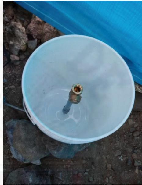
*Figura 35.* Tubería instalada al interior del balde el mismo que fue el soporte del material filtrante.
