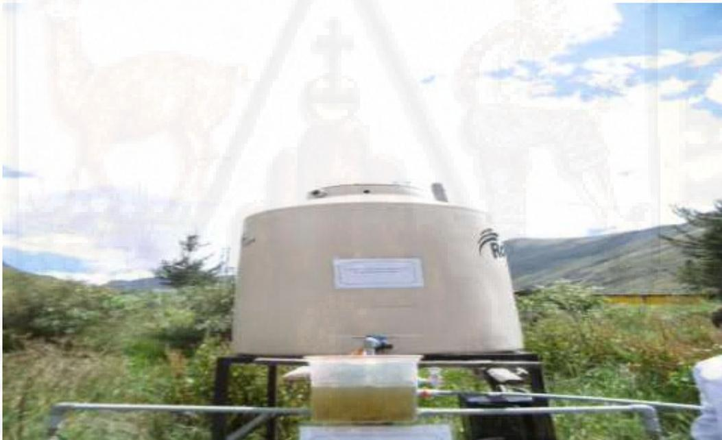
**Figura 55.** Reservorio de 1.1 metros cúbicos que tiene la función de almacenamiento y homogenización de las aguas residuales.
