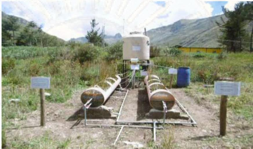
**Figura 11.** Unidades de tratamiento mediante humedales artificiales subsuperficial de flujo horizontal.
