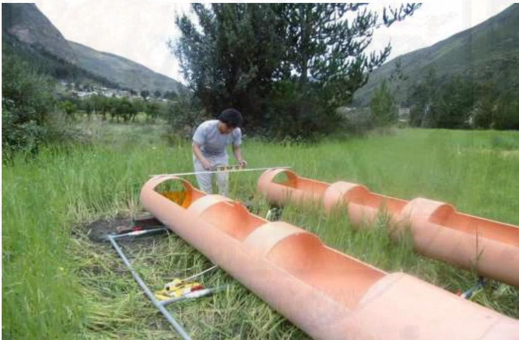
**Figura 51.** Nivelación transversal y longitudinal del humedal artificial tradicional y optimizado.
