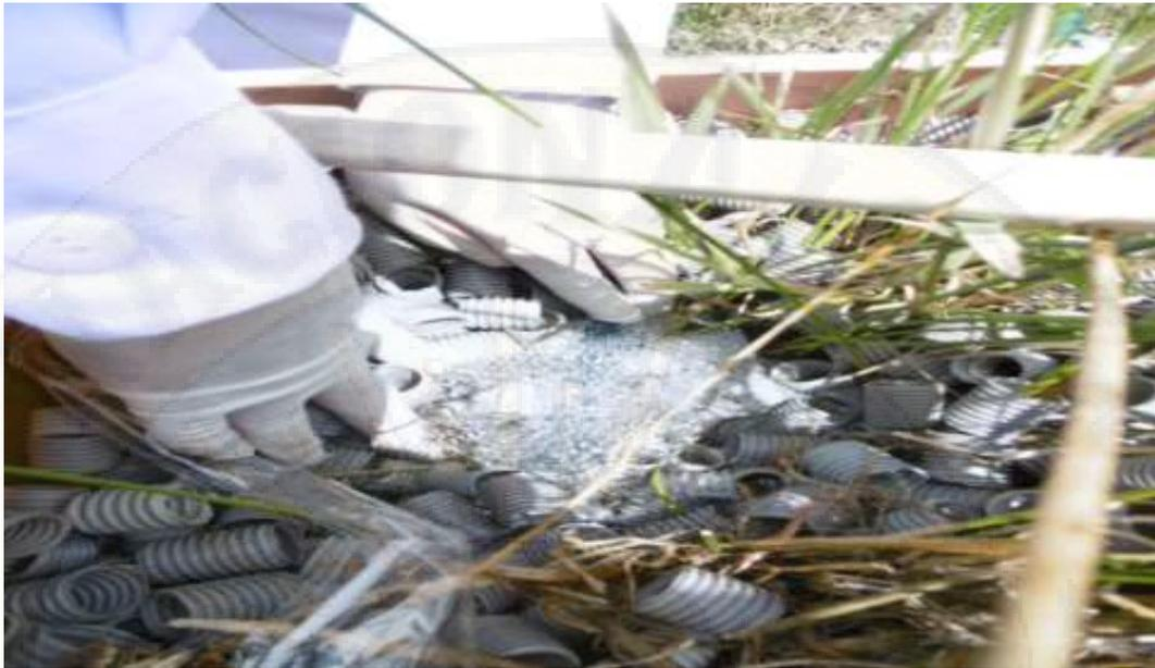
**Figura 58.** Vista de la difusión de oxígeno mediante aireación artificial del compresor de aire.
