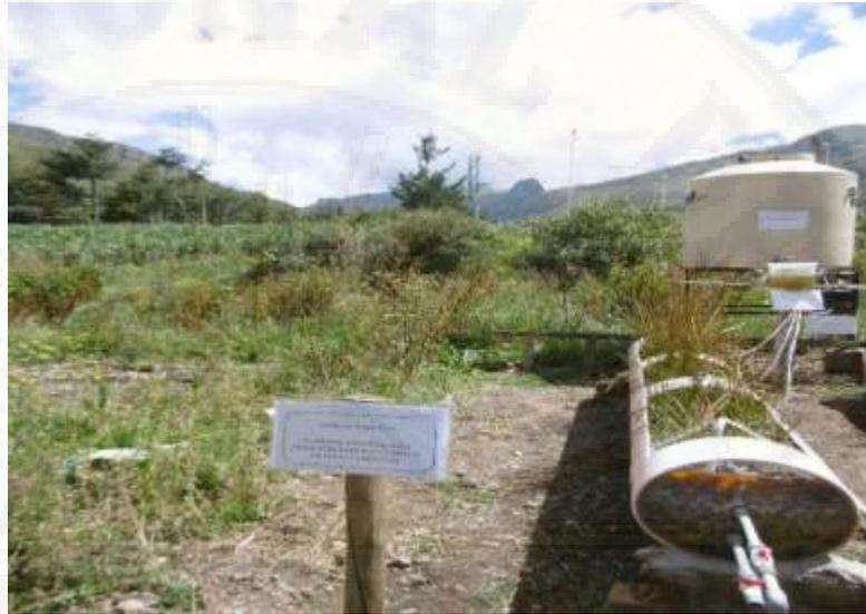
**Figura 15.** Humedal artificial subsuperficial de flujo horizontal de tipo optimizado: medio filtrante sintético (PVC), aireación artificial y totora.
