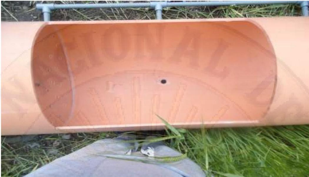
**Figura 52.** Sellado con silicona de alta resistencia las estructuras de vinil y tuberías de PVC.
