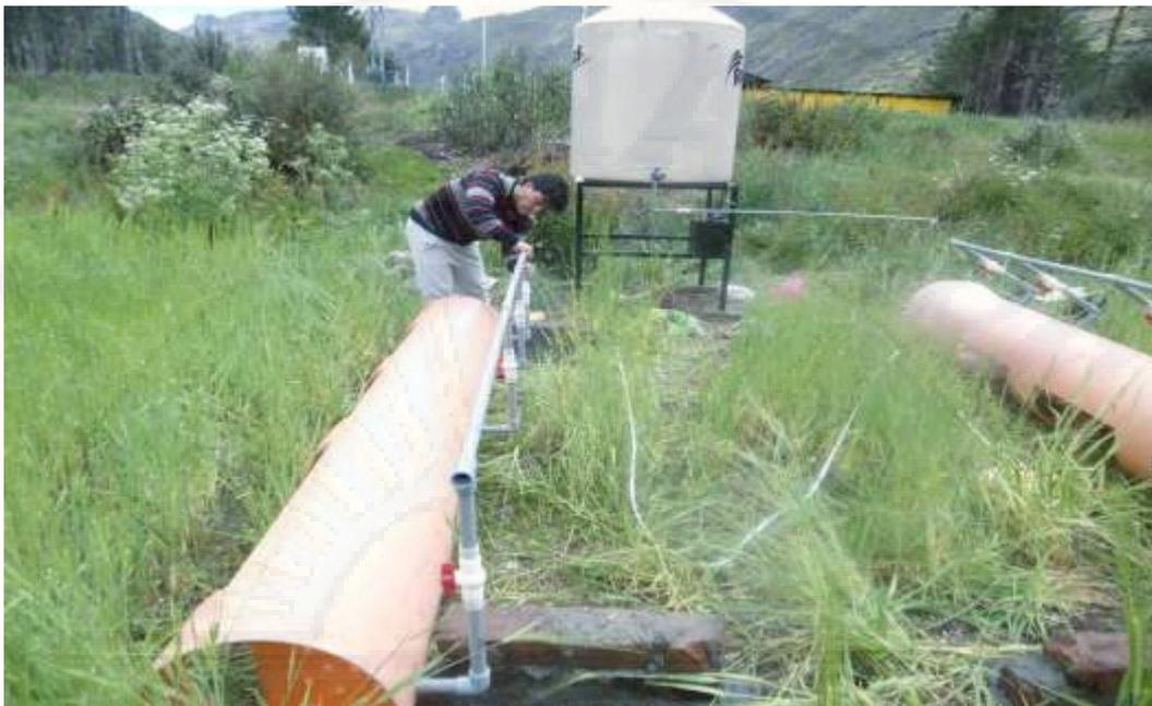
**Figura 50.** Instalación de las tuberías y válvulas para purga de lodos en los humedales artificiales.
